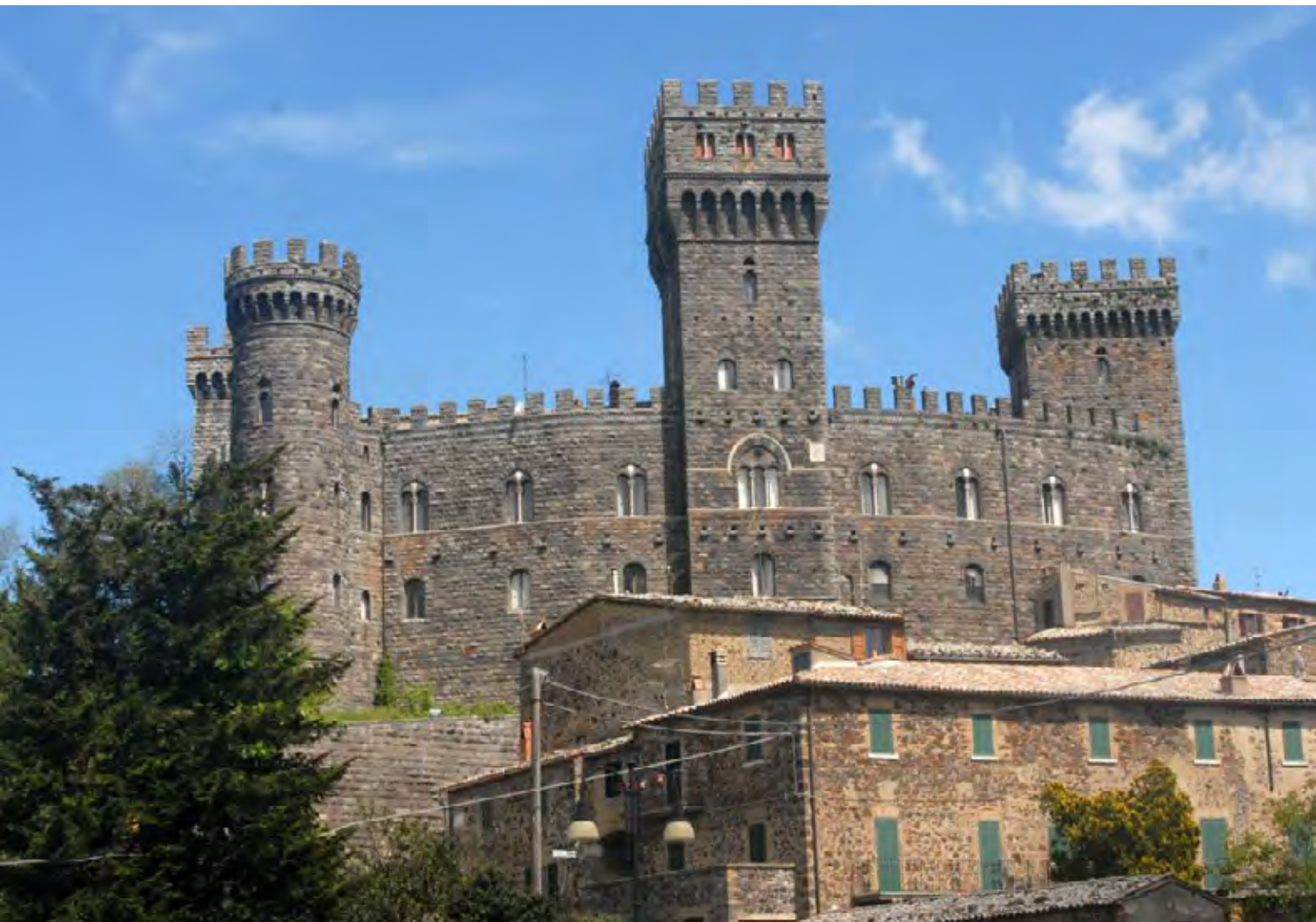
Figura 1. Acquapendente, Viterbo, il fronte principale del castello di Torre Alfina come appare oggi, dopo gli interventi ottocenteschi dell'architetto purista senese Giuseppe Partini (foto D. Esposito).
