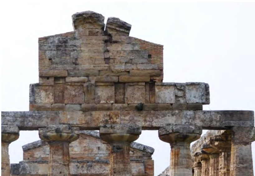
Figura 13. Paestum, tempio di Atena. Fronte orientale. Dettaglio delle integrazioni nel timpano eseguite dall'architetto Ciro Cuciniello con «fabbrica moderna» di mattoni in laterizio (foto S. Pollone, 2016).
