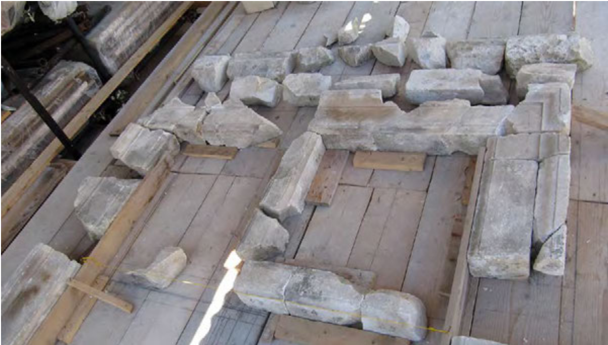
Figura 25. L'Aquila, palazzo Ardinghelli, catalogazione degli elementi lapidei della "finestra guelfa" (foto di S. Cecamore).
