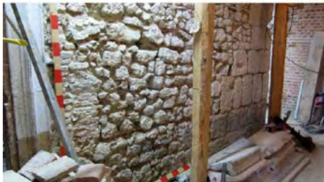
Figura 7 a-d. L'Aquila, palazzo Ardinghelli, muratura di una probabile cellula medievale originaria (foto e rilievi di S. Cecamore).
