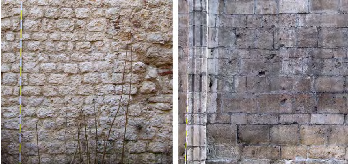
Figura 5 a-b. L'Aquila, "Apparecchio aquilano", chiesa di Santa Croce; apparecchio in conci squadrati e spianati, cattedrale dei Santi Massimo e Giorgio (foto di S. Cecamore).
