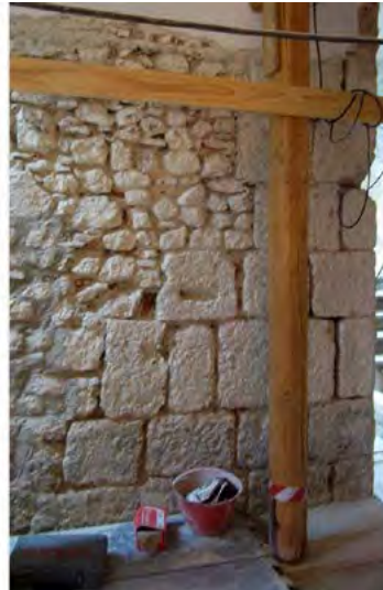
Figura 7 a-d. L'Aquila, palazzo Ardinghelli, muratura di una probabile cellula medievale originaria (foto e rilievi di S. Cecamore).
