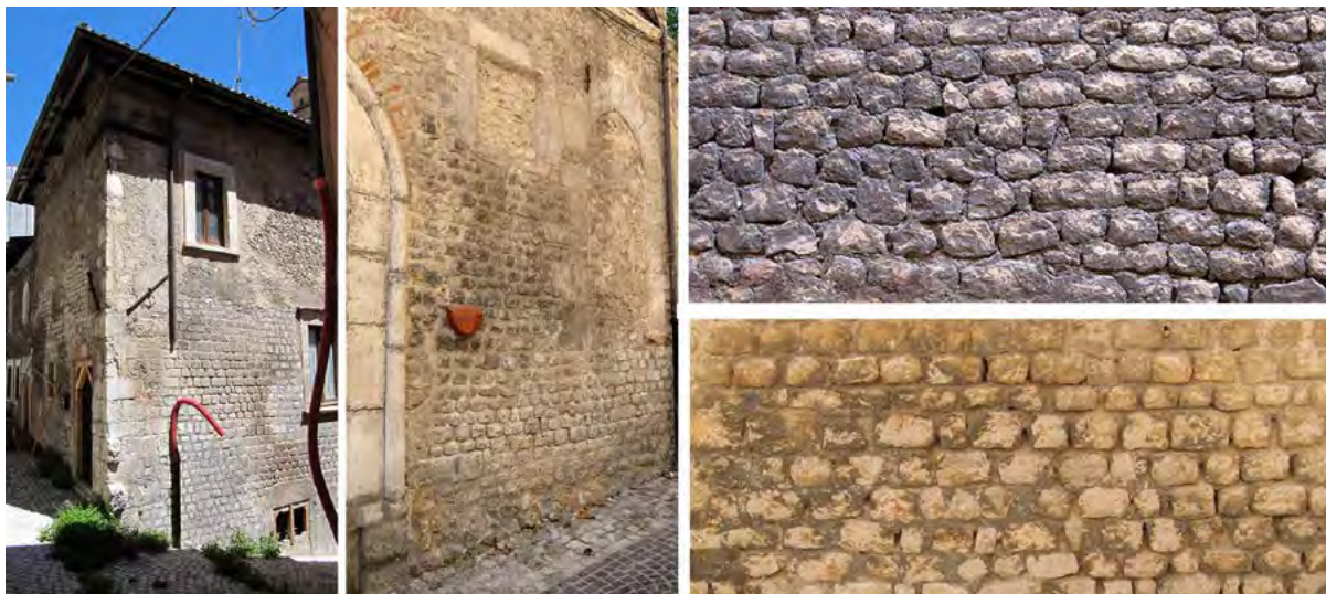
Figura 4 a-d. Murature in “apparecchio aquilano” rilevate nel centro storico dell'Aquila (foto di S. Cecamore).
