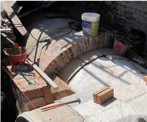
Figura 24 a-b. L'Aquila, palazzo Ardinghelli, ricostruzione dei pilastri e delle volte della loggia (foto di S. Cecamore).
