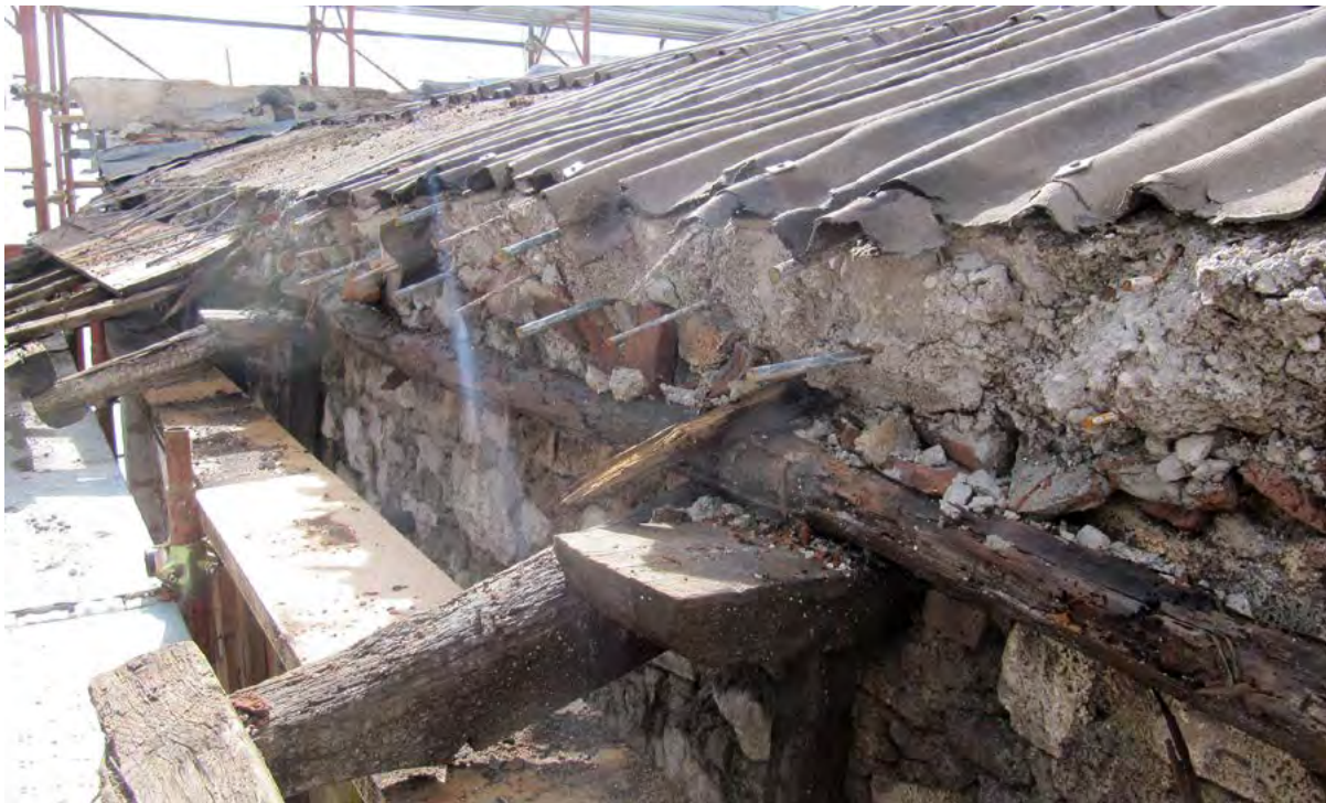
Figura 16. L'Aquila, chiesa dei Santi Marciano e Nicandro, demolizione della copertura in cemento armato (foto di S. Cecamore).
