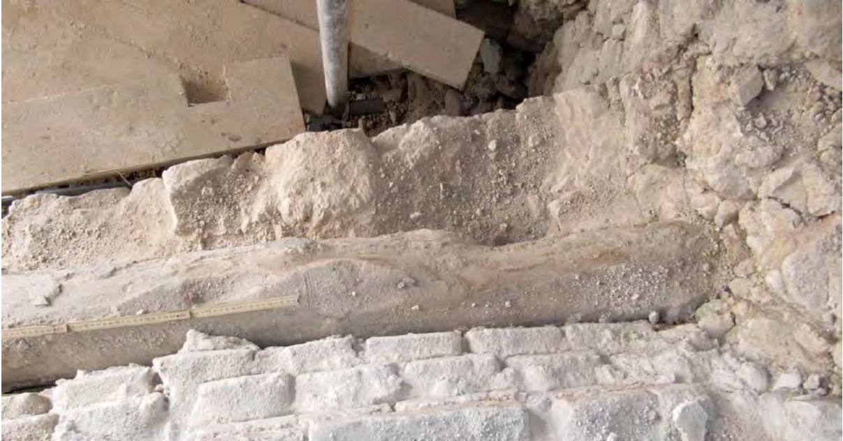
Figura 20. L'Aquila, oratorio di San Giuseppe dei Minimi, catena lignea (foto di S. Cecamore).
