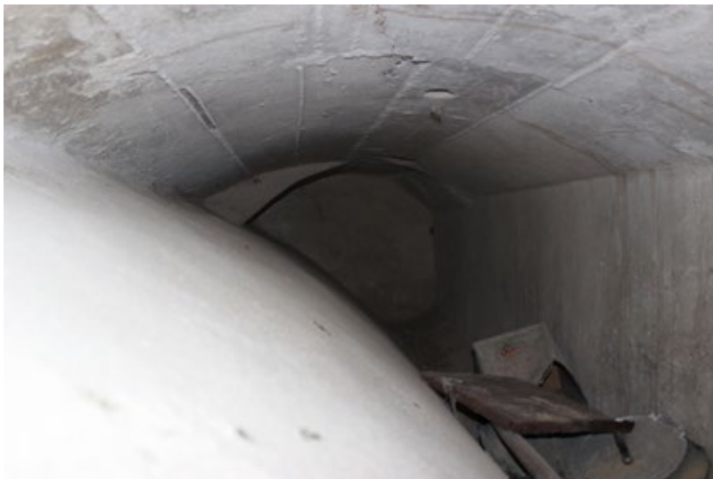
Figura 25. Vano tra l'intradosso della volta di interpiano e la controvoltina in una casa di Granfonte (foto di C.F. Carocci, 2023).
