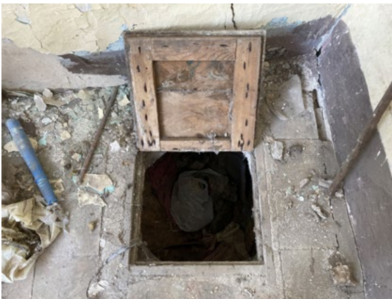
Figura 26. Botola di accesso al vano tra volta e controvoltina sul pavimento del livello superiore in una casa di Granfonte (foto di C.F. Carocci, 2023).
