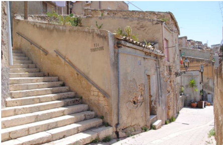
Figura 16. Case su pendio viste da una strada a valle nel quartiere Granfonte (foto di C.F. Carocci, 2023).
