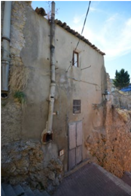
Figura 22. Vista dalla strada a valle di una casa in via Sott'arco (foto di C.F. Carocci, 2023).
