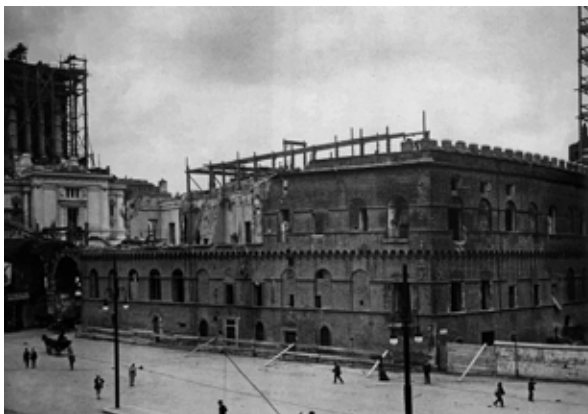
Figure 24-25. Fotografie raffiguranti le fasi di demolizione del palazzetto Venezia, 1910 (da COPPOLA 2012). Si noti il Vittoriano in costruzione, a sinistra, e la torre della Biscia sorretta dai ponteggi, a destra.
