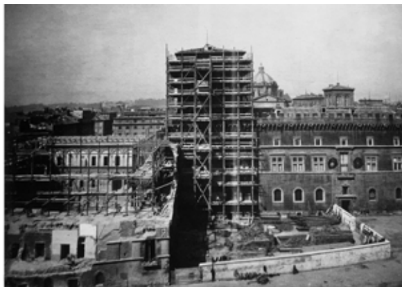
Figure 24-25. Fotografie raffiguranti le fasi di demolizione del palazzetto Venezia, 1910 (da COPPOLA 2012). Si noti il Vittoriano in costruzione, a sinistra, e la torre della Biscia sorretta dai ponteggi, a destra.
