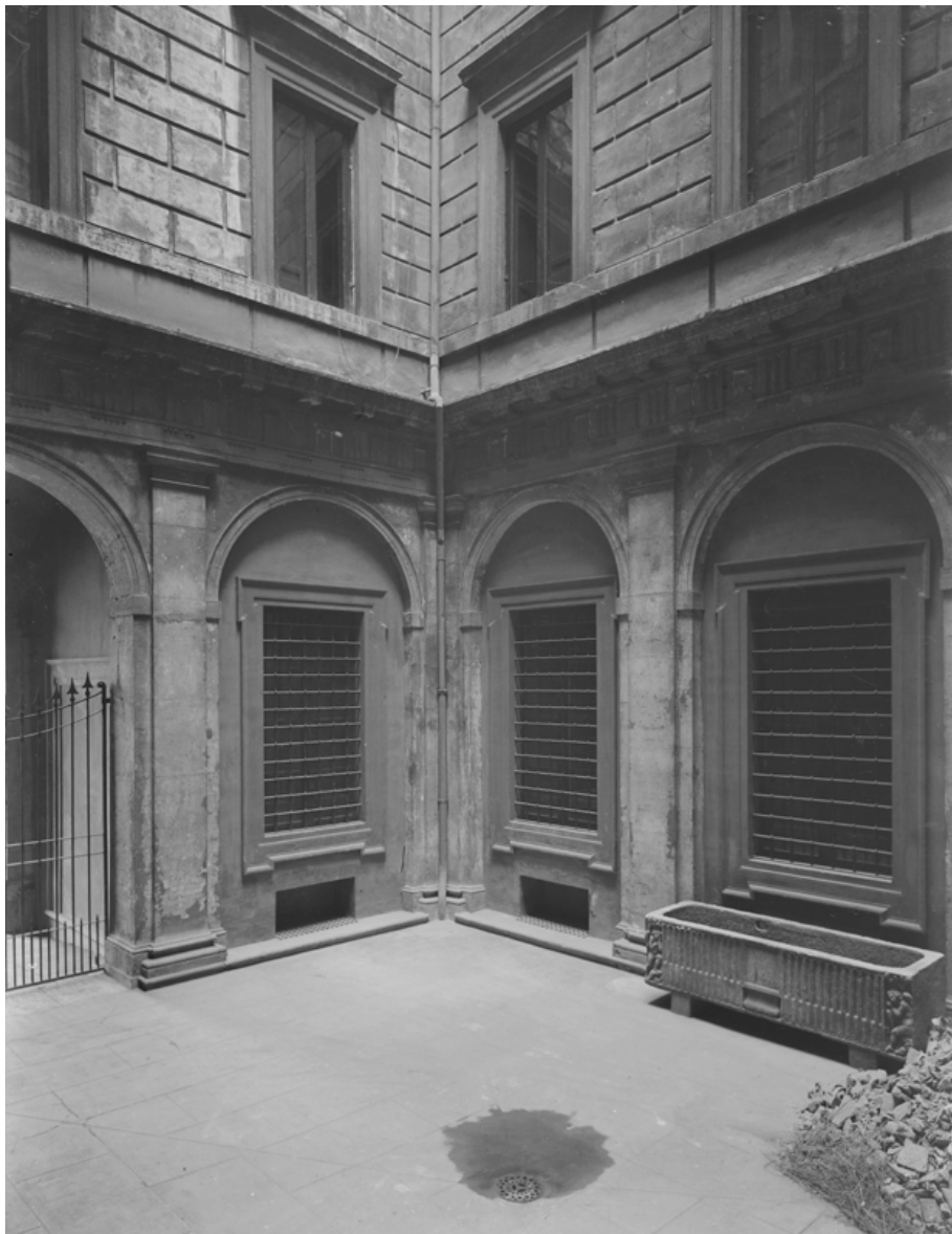
Figura 6. Palazzo Torres-Lancellotti, dettaglio dei lati nord-est del primo cortile (foto Istituto Centrale per il Catalogo e la Documentazione, etichetta BCS).
