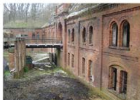
11. Fort III - Poznan (Polonia) Stato di abbandono
