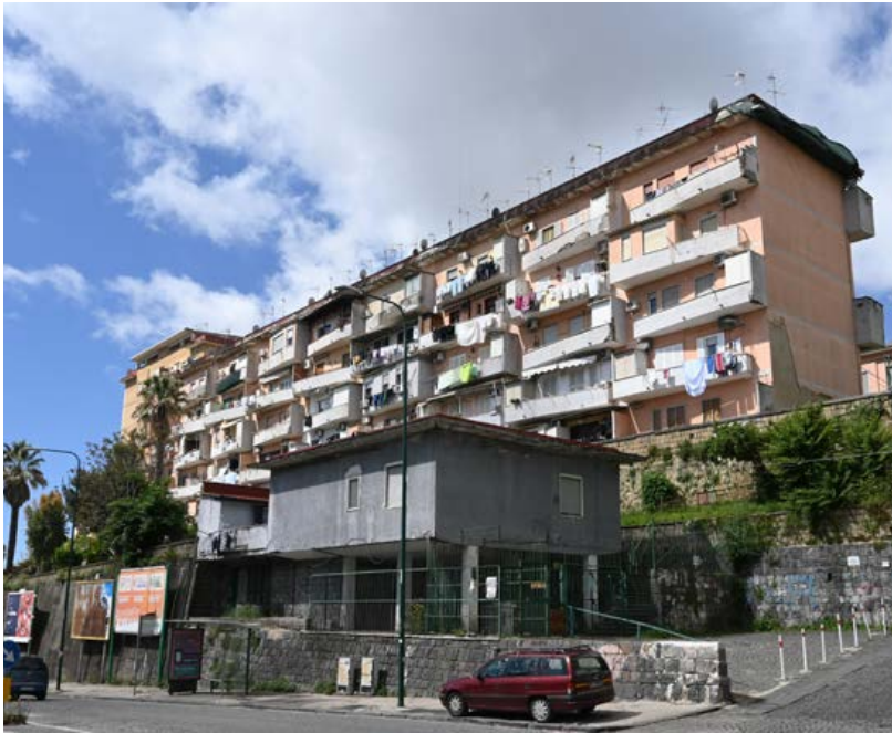
Figura 17. Stefania Filo Speziale, rione a Capodichino (Parco Sirio), edificio a cinque piani su Calata Capodichino e alloggio del custode (foto C. De Falco, 2022).
