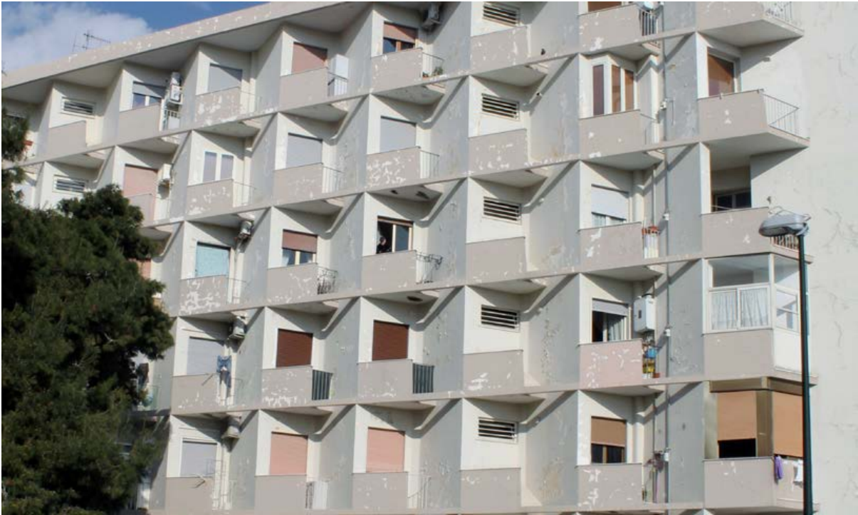
Figura 26. Stefania Filo Speziale, quartiere ad Agnano, particolare del prospetto di un edificio alto con i balconi ruotati a 45 gradi, 1953 (foto C. De Falco, 2018).
