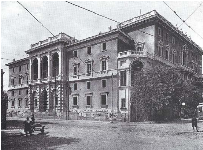
Figura 13. Roma, piazzale delle Belle Arti, blocco sud di Giulio Gra, foto del fronte su via Flaminia (da AGGARBATI, SAGGIORO 1991, p. 104).
