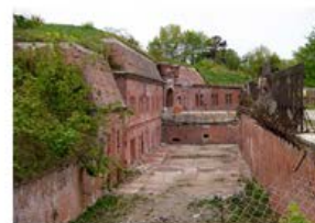
12. Fort IX - Thorn/Torun (Polonia) Stato di abbandono
