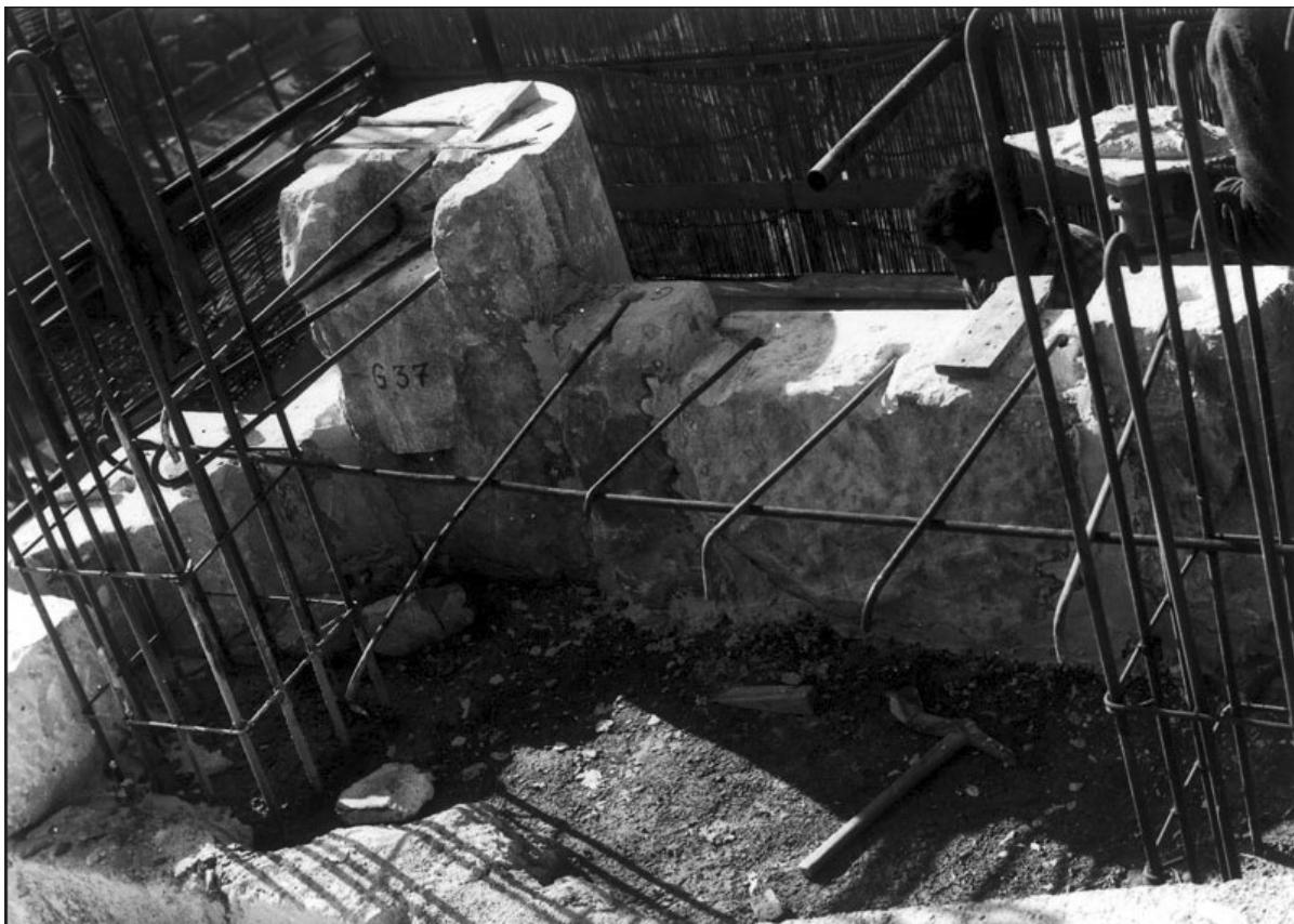
Figura 11. L'Aquila, basilica di San Bernardino. Una foto di dettaglio mostra le armature dei pilastri e le staffe di collegamento con gli elementi lapidei ricollocati (da <https://www.impresacingoli.it/basilica-di-san-bernardino/>; ultimo accesso 23 giugno 2023). Per l'uso delle riprese fotografiche, si ringrazia la Direzione Centrale degli Affari dei Culti e per l'Amministrazione del Fondo Edifici di Culto del Ministero dell'Interno, in qualità di Soggetto proprietario.
