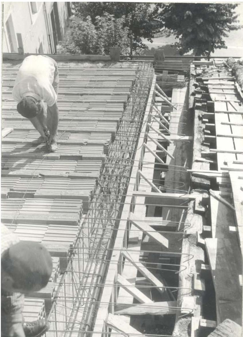
Figura 12. L'Aquila, basilica di San Bernardino. Il rifacimento delle coperture fu compiuto sostituendo la struttura lignea con solai in laterocemento e cordoli in calcestruzzo armato. SABAP-AQ, archivio fotografico, neg. 7741, anno 1960. Uso immagine su autorizzazione del MiC – Soprintendenza ABAP per le province di L'Aquila e Teramo (SABAP-AQ).
