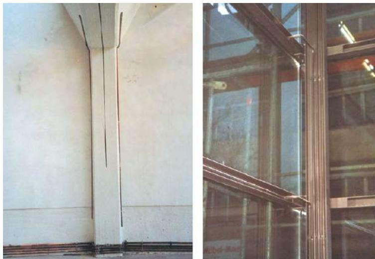
Figure 3a-b. Alf Lechner Museum, Ingolstadt, Sistema di temperierung installato a pavimento e su serramento esterno.
