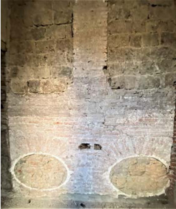
Figura 8. Caserta, Palazzo de Gregorio, fronte originario della scala nel braccio orientale (foto M.G. Pezone, 2021).
