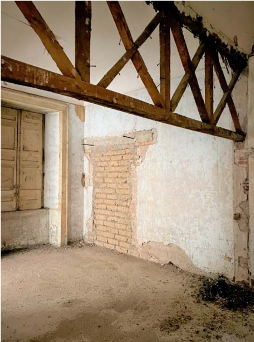
Figura 20. Caserta, Palazzo de Gregorio, resti di un graticcio ligneo di un tramezzo «intelaiato di fabbrica» (foto M.G. Pezone, 2021).
