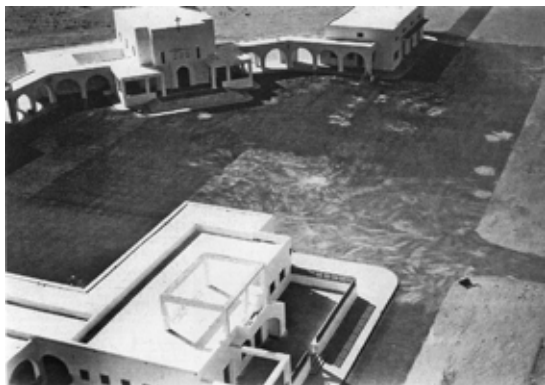
Figura 21. Bir Terrina (Tripoli), villaggio Giulio Giordani, Umberto Di Segni, veduta generale (da CULOTTA, GRESLERI, GRESLERI 2007, p. 227).
