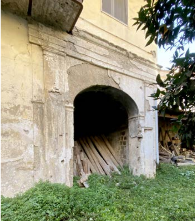
Figura 11. Caserta, Palazzo de Gregorio, antica rimessa nel cortile con resti della decorazione a stucco (foto M.G. Pezone, 2021).
