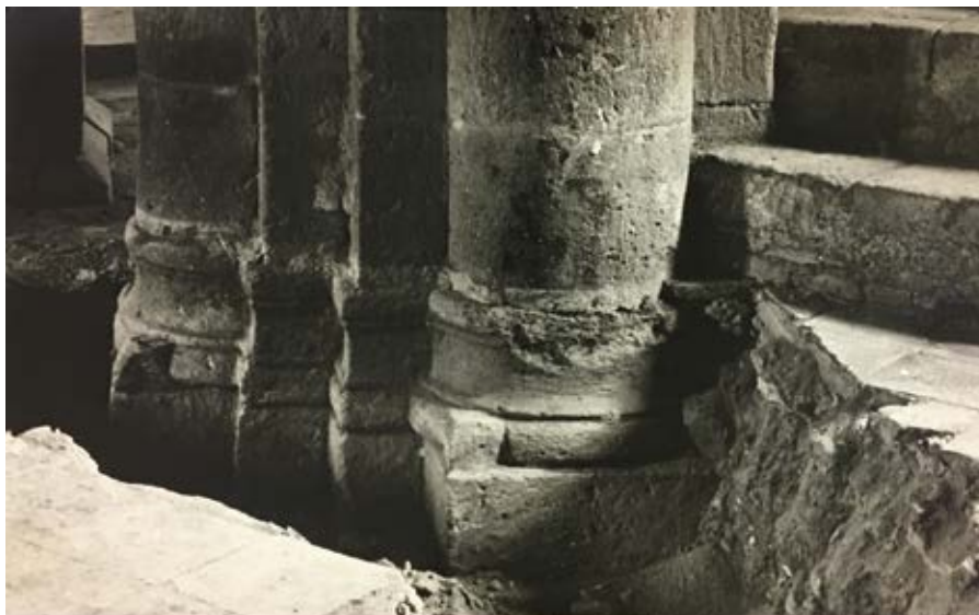
Figura 17. Dettaglio dell'intervento di demolizione del presbiterio in corrispondenza del pilone destro, foto di Luigi Leporini (foto ASICAP).
