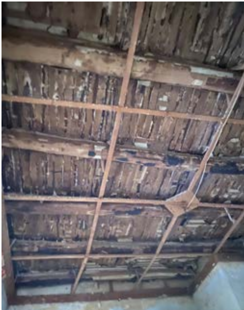
Figure 17-19. Caserta, Palazzo de Gregorio, solai di copertura in legno di diversi ambienti, particolari (foto M.G. Pezone, 2021).
