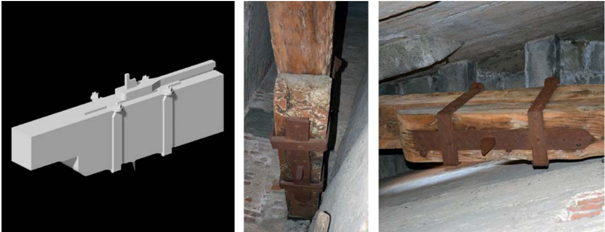
Figura 10a-c. Giunti di tipologia D: modello 3D, vano 22 e vano 15 (foto ed elaborazione S. Celli, F. Ottoni, 2018).
