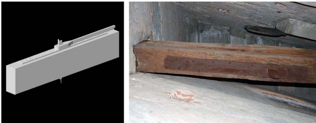
Figura 12a-b. Giunti di tipologia F: modello 3D e vano 1 (foto ed elaborazione S. Celli, F. Ottoni, 2018).
