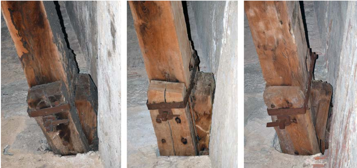
Figure 4a-c. I tre giunti rappresentati in figura (da sinistra a destra: vano 10, 13 e 19) mostrano in maniera abbastanza evidente alcuni dettagli del sistema di connessione che non compaiono nel rilievo del Nelli (foto S. Celli, 2018).
