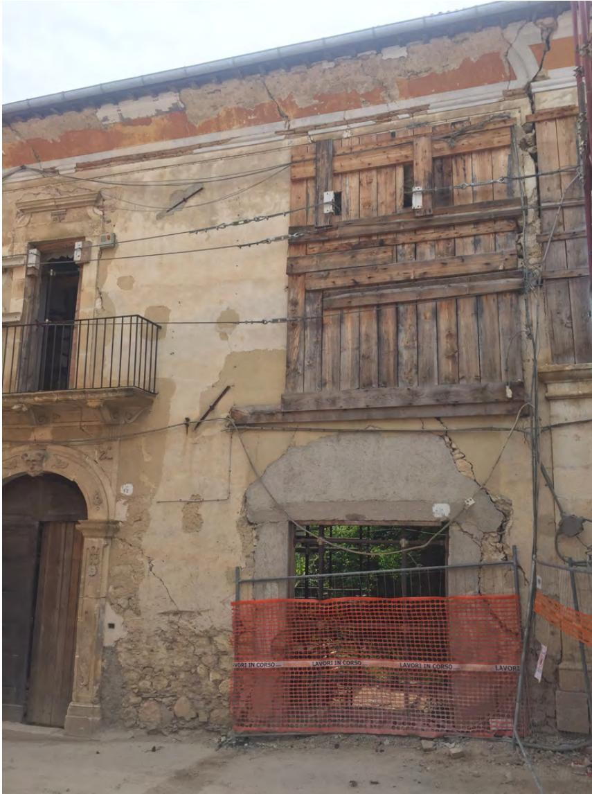
Figura 7. Villa Sant'Angelo (AQ), palazzo De Matteis in via Madonna delle Prata, giugno 2020. L'apertura di un garage sul fronte dell'edificio, in prossimità dell'angolo, ha ridotto la sezione resistente della muratura e concentrato i carichi sulle porzioni residue gravemente lesionate dalle sollecitazioni sismiche (foto C. Bartolomucci, 2020).
