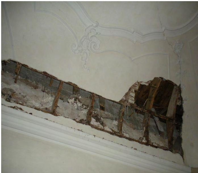
Figura 5. L'Aquila, monastero di San Basilio, gennaio 2010. Il danno sulla volta di controsoffitto ha reso visibile la struttura lignea della volta settecentesca, ornata da stucchi all'intradosso (gennaio 2010). In alcuni casi sono riemersi, al di sopra dei controsoffitti, finiture e intonaci dipinti che documentano configurazioni precedenti (foto C. Bartolomucci, 2010).
