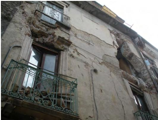
Figura 3. L'Aquila, porzione di fronte edificato su via Bominaco, agosto 2009. Si osservano i collassi delle porzioni murarie tra le finestre e la sopraelevazione di un piano; le lesioni verticali tra le due finestre del livello intermedio sembrano indicare un'apertura preesistente (foto C. Bartolomucci, 2009).
