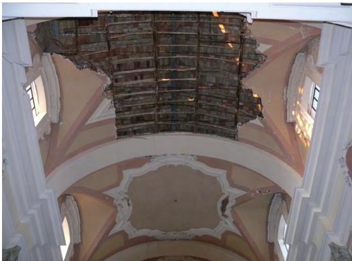
Figura 6. L'Aquila, chiesa di san Domenico (interno), ottobre 2009. Attraverso la caduta parziale della volta è possibile vedere la tecnica costruttiva (controsoffitto in telaio ligneo e incannucciata, rivestito all'intradosso da intonaco e stucchi) e, sullo sfondo, il tetto in laterocemento di recente sostituzione (foto C. Bartolomucci, 2009).
