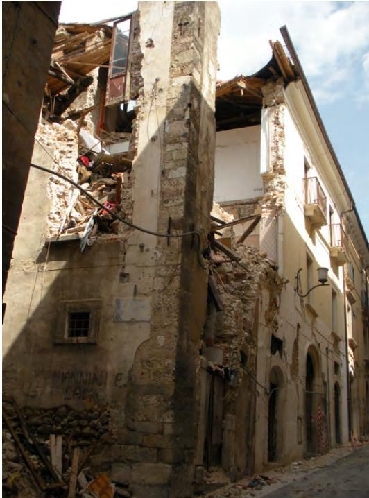
Figura 2. L'Aquila, edificio in via Paganica, angolo via San Benedetto in Perillis, agosto 2009. La compattezza del cantonale rimasto in piedi (oggi demolito) e l'interruzione dei tiranti, i cui capichiave sono ancora visibili, fa supporre che il crollo sia dovuto a cedimenti localizzati (foto C. Bartolomucci, 2009).
