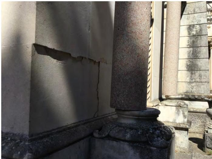
Figura 14. L'Aquila, Cimitero Monumentale, maggio 2020. Particolare del dissesto di una cappella gentilizia. Le colonne si presentano ancora oggi in una pericolosa situazione di instabilità; l'area è transennata ma non è stato adottato alcun provvedimento per evitare ulteriori danni da sovraccarico (foto C. Bartolomucci, 2020).
