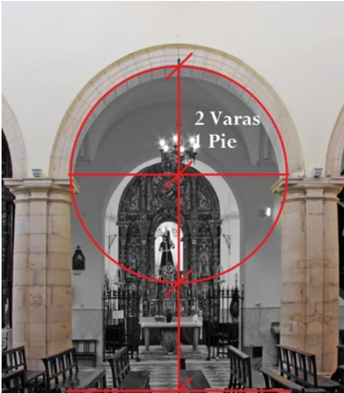
Figura 18. Arcadas en piedra que separan la nave central de las laterales, dando paso a capillas perimetrales (foto M. Gómez Bernardi, 2008).
