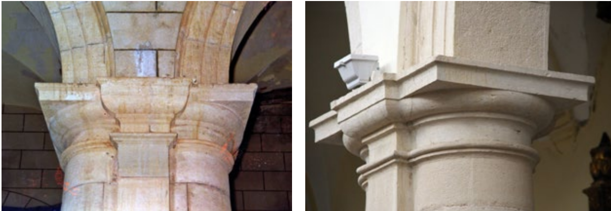
Figura 3. Melilla, iglesia de la Purísima Concepción. A la izquierda, detalle de los soportes híbridos que sustentan los arcos formeros (foto A. Bravo Nieto, S. Ramírez González, 1997); a la derecha, figura 4. Pormenor del capitel de las columnas (foto A. Bravo Nieto, S. Ramírez González, 2004).
