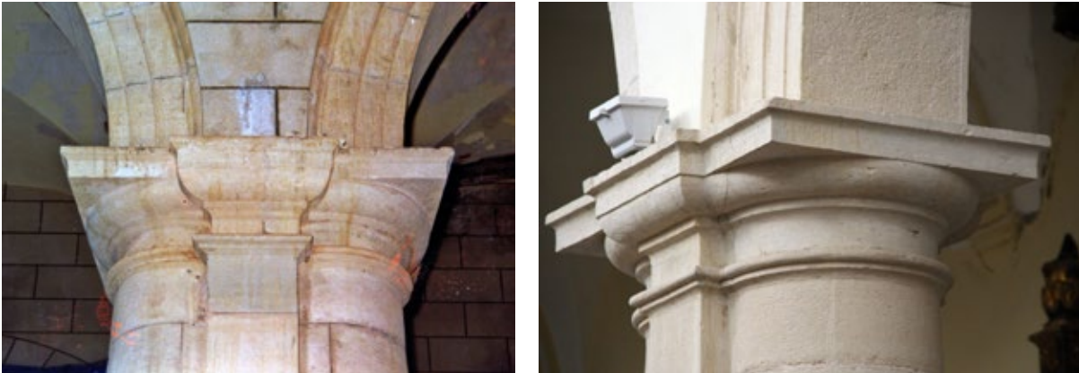
Figura 3. Melilla, iglesia de la Purísima Concepción. A la izquierda, detalle de los soportes híbridos que sustentan los arcos formeros (foto A. Bravo Nieto, S. Ramírez González, 1997); a la derecha, figura 4. Pormenor del capitel de las columnas (foto A. Bravo Nieto, S. Ramírez González, 2004).
