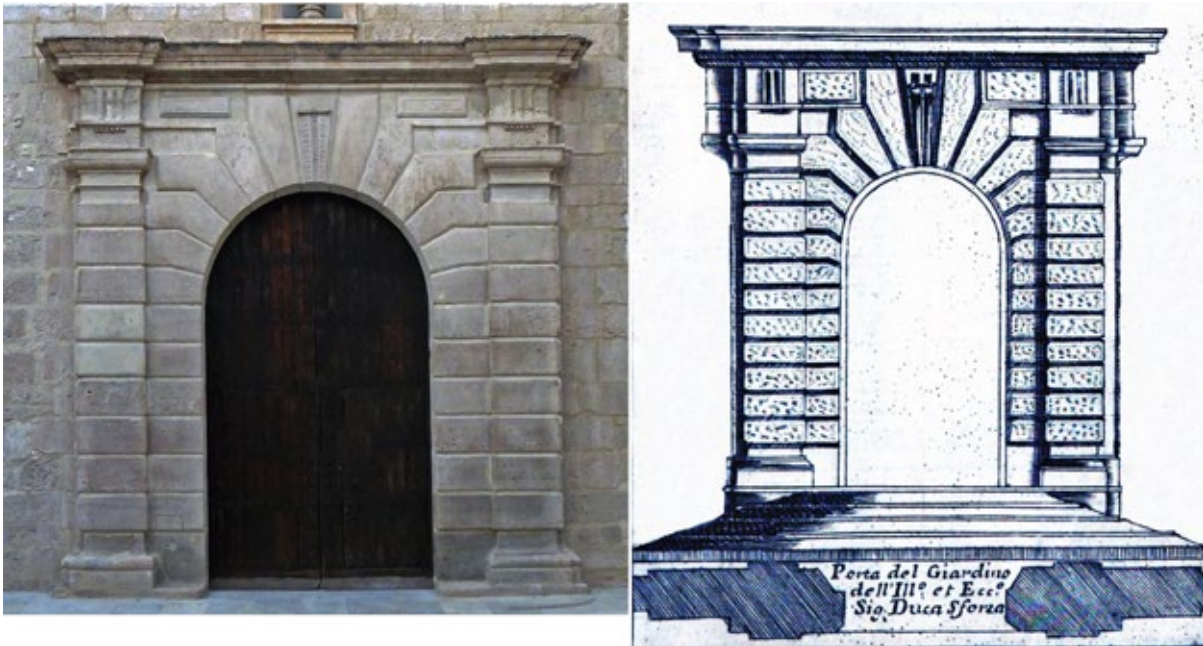
Figuras 13a-b. Portada exterior de la iglesia de Melilla (2017) y grabado utilizado de prototipo extraído del tratado de Vignola (foto A. Bravo Nieto, S. Ramírez).
