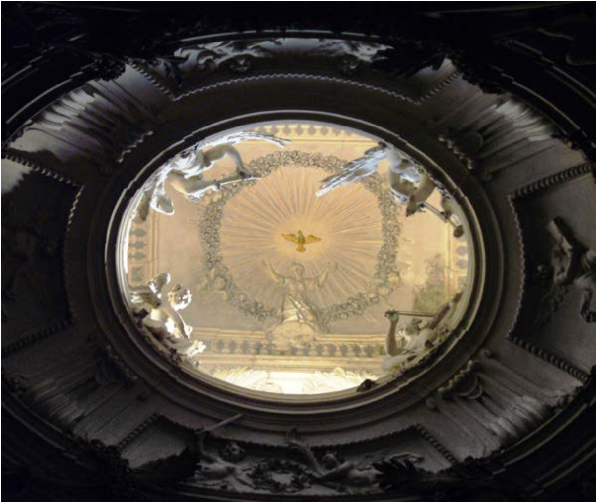
Figura 2. Roma. Chiesa di San Carlo ai Catinari, angeli poggiati sulla balaustra all'interno della cappella di Santa Cecilia ( https://commons.wikimedia.org/wiki/File:S_Eustachio_-_san_Carlo_ai_Catinari_cappella_s_Cecilia_lanterna_1050547.JPG , ultimo accesso 20 aprile 2021).
