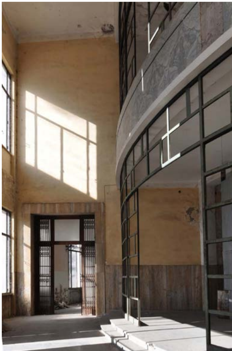
Figura 5. Predappio (Forlì-Cesena). Casa del Fascio. Dettaglio dell'atrio con vetrata scorrevole in ferro al livello terreno e al livello superiore, in corrispondenza del pianerottolo dello scalone (da DELIZIA ET ALII 2015, p. 68).
