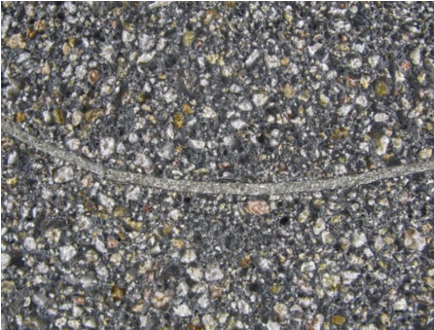
Figura 22. AFF, Schloss Freudenstein, Freiberg, 2008-2010, dettaglio della lavorazione del calcestruzzo (foto A. Rosellini, 2010).
