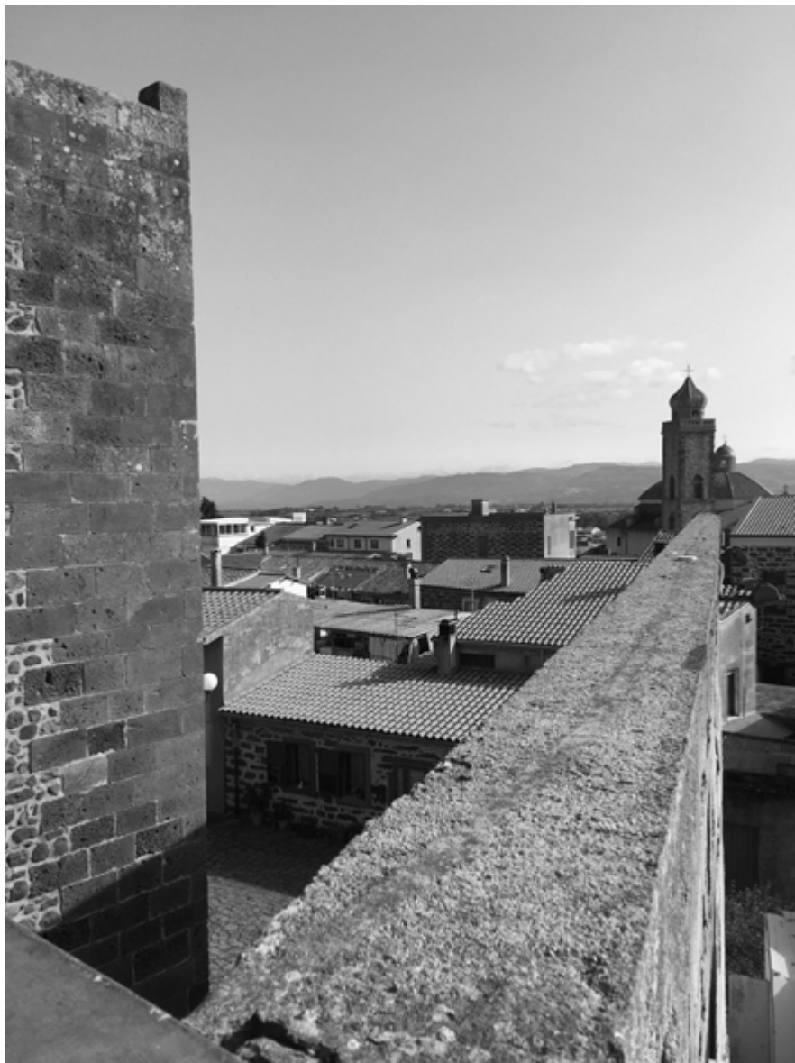
Figura 25. Ghilarza (OR), donjon aragonese, vista panoramica verso sud-est ripresa dalla scala di accesso al primo livello (foto V. Pintus, 2019).
