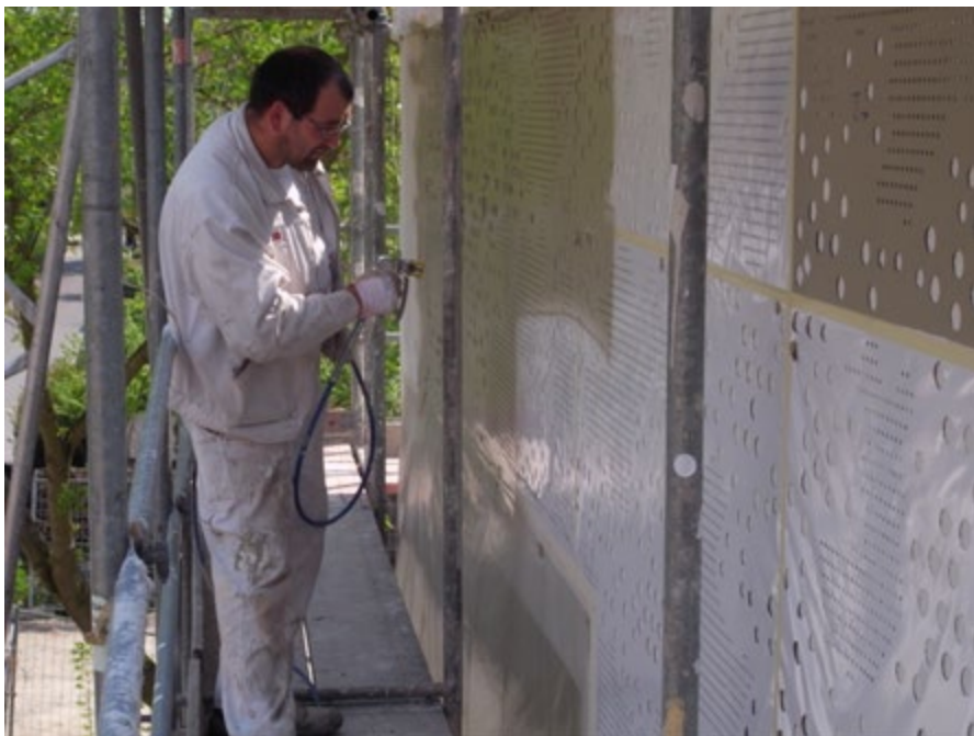
Figura 30. AFF, Gemeinschaftsschule Anna Seghers, Berlin-Adlershof, 2008-2010, fotografia di cantiere. AAFBB.
