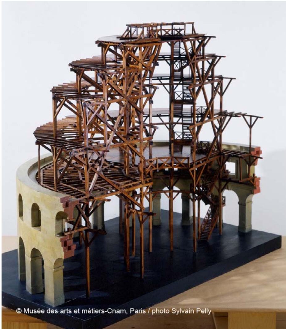
Figure 6. Agence Bélanger, Maquette: échafaudage construit pour la pose de la coupole en fer de la Halle au Blé de Paris, 1811-1812. Paris, Conservatoire national des arts et métiers (©Musée des arts et métiers-Cnam/photo S. Pelly).
