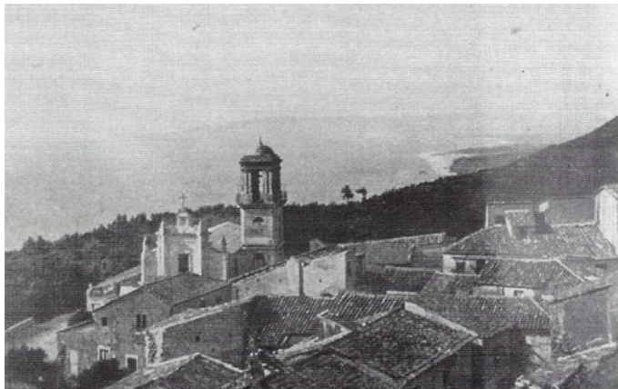
Figura 15. Palmi (RC), chiesa del Carmine (archivio privato A. Genovesi).
