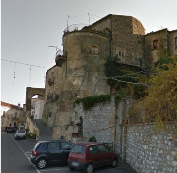
Figura 43. Rocca Imperiale (CS). La torre urbana incassata nelle mura nei pressi della Porta di mezzo (da Google Earth).
