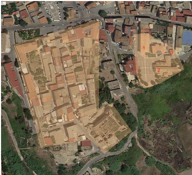
Figura 37. Isola di Capo Rizzuto (KR). Veduta aerea: a sinistra è campita l'area della città cinquecentesca con il castello; a sinistra l'area in cui si trovano il Palazzo vescovile (1), la Cattedrale (2) e la torre trasformata in campanile (3). (da Google Earth, elaborazione a cura di B. Mussari).
