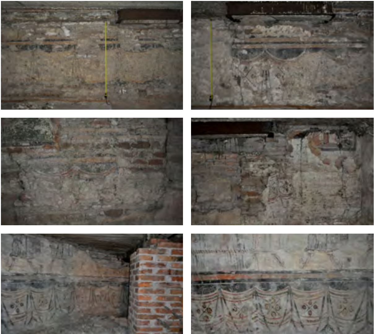
Figura 15. Velari delle pareti longitudinali e dell'abside. Dall'alto in senso orario: a) zona centrale della parete sud (I5); b) angolo est della parete sud (I3); c) zona centrale della parete nord (I3); d) angolo est della parete nord (I3 e, sotto, I14); e) e f) abside (I3) (foto S. Cutarelli).
