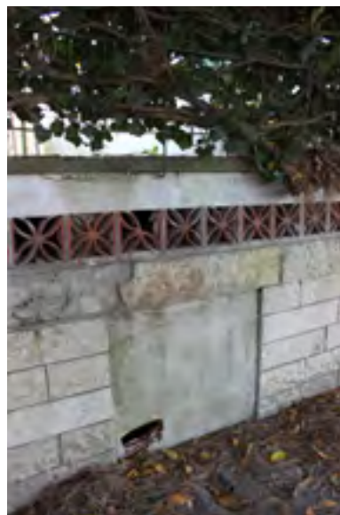
Figure 21-22. Cervia (RA), bunker a servizio di un'abitazione. Si noti il tentativo di ingentilirne l'aspetto tramite il rivestimento e l'impiego di gelosie in terracotta (foto A. Zampini, 2018).
