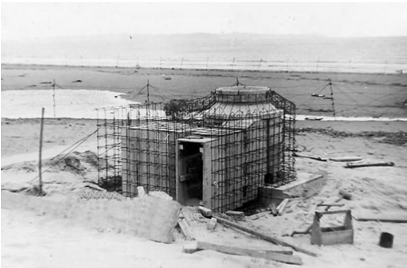
Figura 9. Esempio di un Bauform Ringstand , noto comunemente come Tobruk , in costruzione ( https://upload.wikimedia.org/wikipedia/commons/2/21/Esempio_di_costruzione_di_un_Tobruk.jpg : ultimo accesso 18 dicembre 2017).
