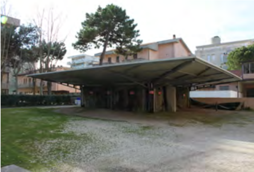
Figura 24. Lido di Savio (RA), bunker coperto da pensilina metallica utilizzato quale parcheggio coperto e cantina (foto C. Mariotti, 2018).
