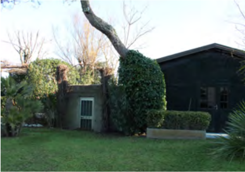
Figura 19. Cervia (RA). Bunker convertito a magazzino per attrezzature sportive (foto C. Mariotti, 2018).
