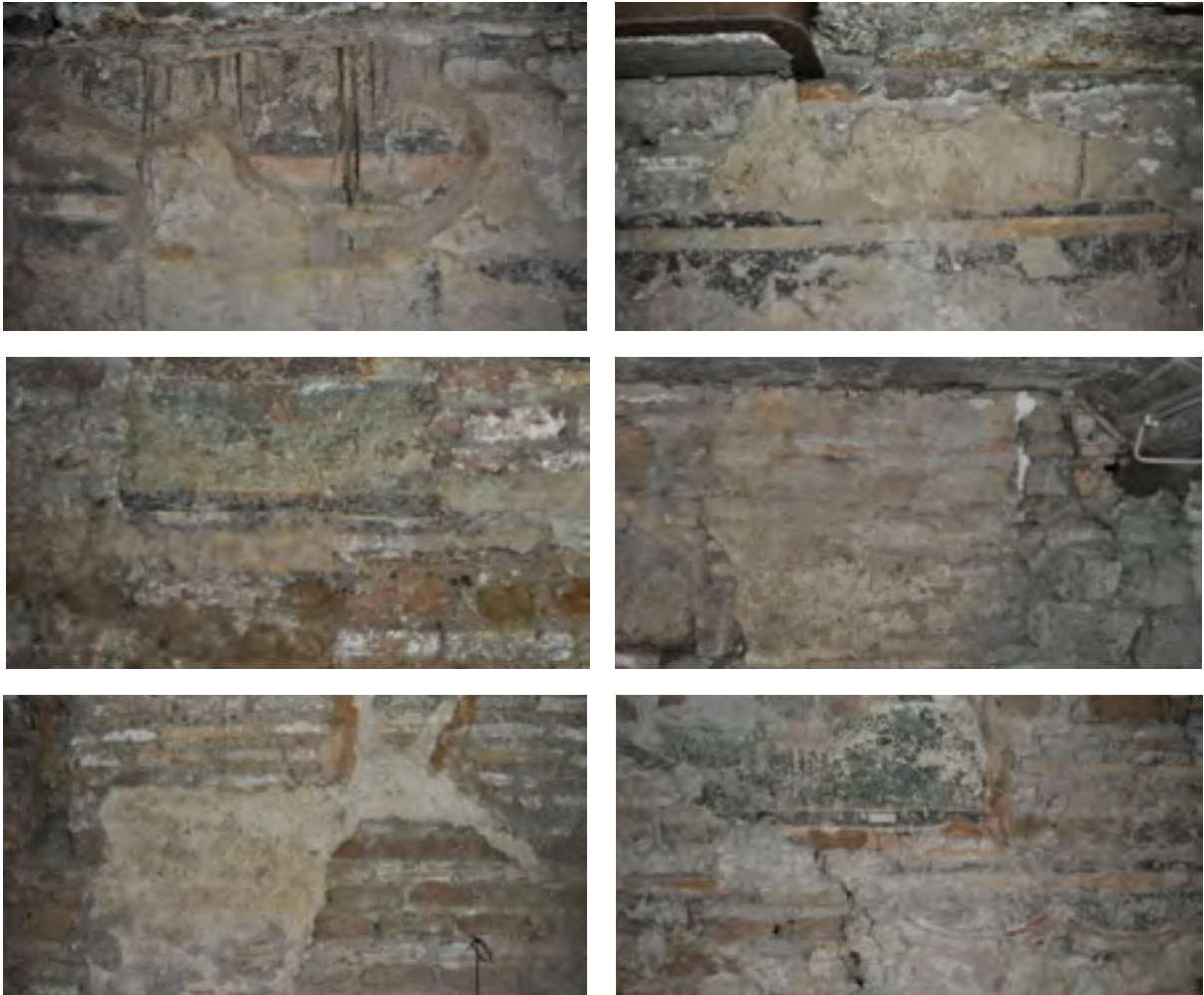
Figura 16. Relazioni stratigrafiche fra i dipinti dello zoccolo e del registro superiore. Dall'alto, in senso orario: parete sud: a) continuità fra i vela meno recenti e il secondo registro con figure stanti (I3); b) sovrapposizione dell'intonaco bianco (I6) ai vela più recenti (I5); c) accostamento della cornice dei panneggi più recenti (I3) al bordo tagliato del brano a fondo verde (I5?); controfacciata: d) continuità fra la finta crusta marmorea e il registro superiore (I5?); parete nord: e) continuità fra lo zoccolo e il registro superiore (I12, strato di preparazione di I5); f) accostamento della cornice dei vela più recenti (I3) al bordo tagliato del brano a fondo verde (I5?) (foto S. Cutarelli).
