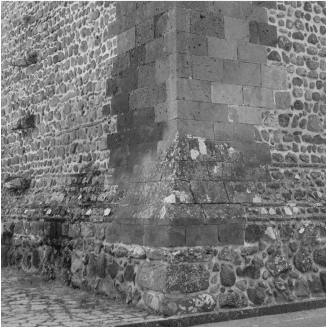
Figura 11. Ghilarza, Donjon. La fabbrica è realizzata prevalentemente con un unico litotipo, il basalto, impiegato in forme diverse: lavorato (conci squadri), semilavorato (bozze) e non lavorato (grossi trovanti impiegati nel basamento) (foto V. Pintus 2015).
