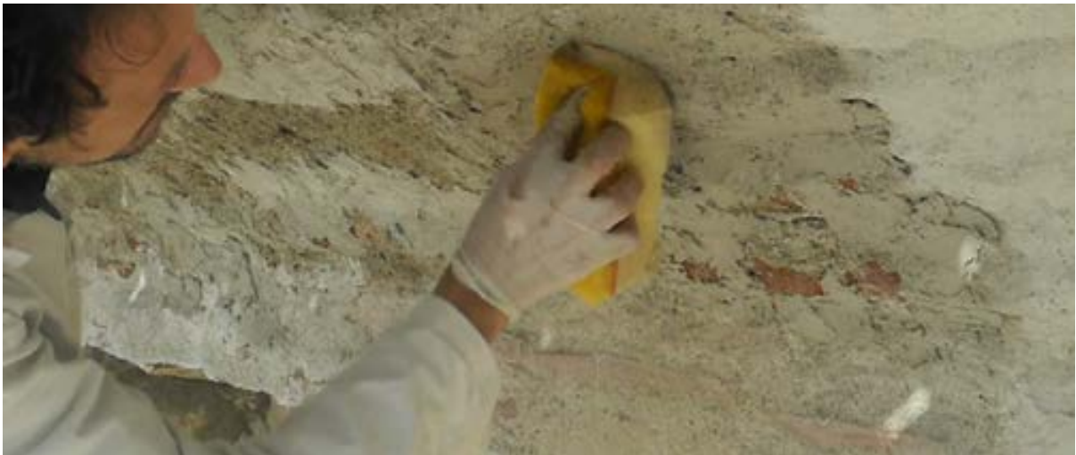
Figure 28-29. Savona, santuario di Nostra Signora della Misericordia, fronte principale dell'Ospizio dei poveri. Applicazione a spatola della malta di calce e successivo “ripassamento” a spugna bagnata (foto S.F. Musso, 2013).
