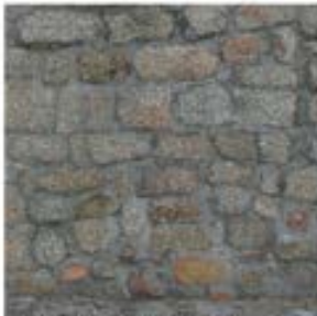
02 | Castello di Balassano - Loggionto Chiesa polifona | GRANITO
