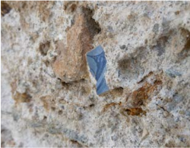
Figura 40. Savona, santuario di Nostra Signora della Misericordia, fronte principale dell'Ospizio dei poveri. Coccio in ceramica databile alla prima metà del XVII secolo individuato nel corpo dell'intonaco dopo l'installazione dei ponteggi (foto S.F. Musso, 2012).
