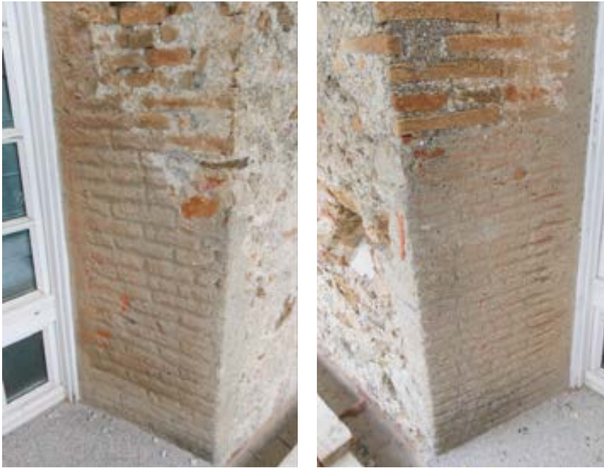
Figura 20. Savona, santuario di Nostra Signora della Misericordia. Fronte principale dell'Ospizio dei poveri. Particolare della strombatura esterna di una finestra del primo piano. Nella parte inferiore si nota la finitura con intonaco graffito che imita un paramento in mattoni pieni. La differenza rispetto alla muratura superiore indica che, in una fase successiva alla sua realizzazione, la finestra è stata ampliata verso l'esterno e verso il basso (foto S.F. Musso, 2012).
