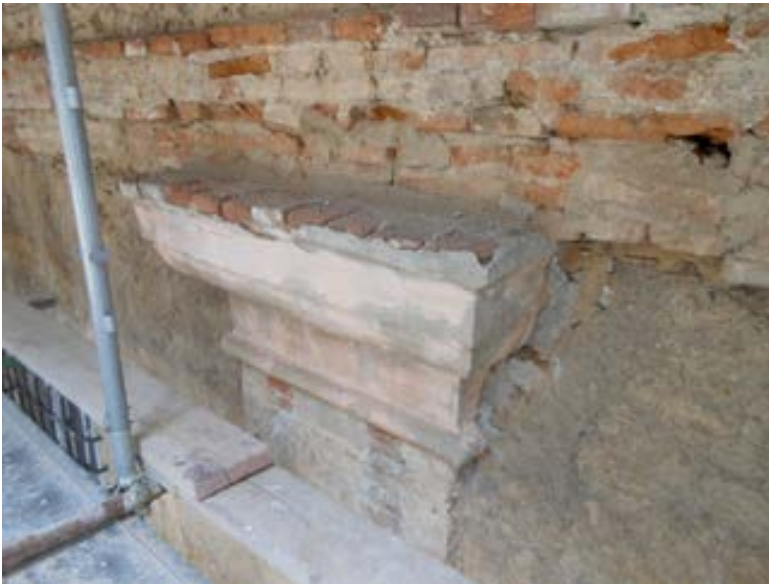
Figura 17. Savona, santuario di Nostra Signora della Misericordia, fronte principale dell'Ospizio dei poveri. Capitello in mattoni pieni rivestito con malta di calce aerea e finitura cromatica a imitazione della pietra di Finale (foto S.F. Musso, 2012).
