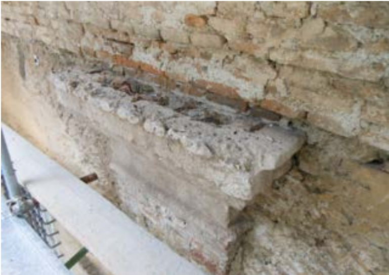
Figura 16. Savona, santuario di Nostra Signora della Misericordia, fronte principale dell'Ospizio dei poveri. Capitello in pietra di Finale, probabilmente di reimpiego, come dimostra l'incavo nella parte superiore forse destinato ad accogliere un altro elemento (foto S.F. Musso, 2012).
