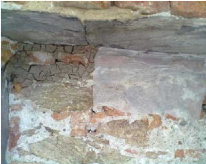
Figure 18-19. Savona, santuario di Nostra Signora della Misericordia, fronte principale dell'Ospizio dei poveri. Sopra, sottili lastre in ardesia impiegate come sagome “a perdere” nel cornicione; sotto, lastre più spesse a sostegno della cornice sommitale (foto S. Musso, 2012).
