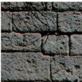
09 | Palazzo di Re Baldo, Loriggionto Palazzo | GRANITO
