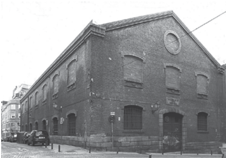
Figura 4. Veduta della Central Eléctrica de Mediodía a Madrid prima dell'intervento di trasformazione ( http://www.aq.upm.es/historiaetsam/ETSAM/directores3/lopez_otero.html ).
