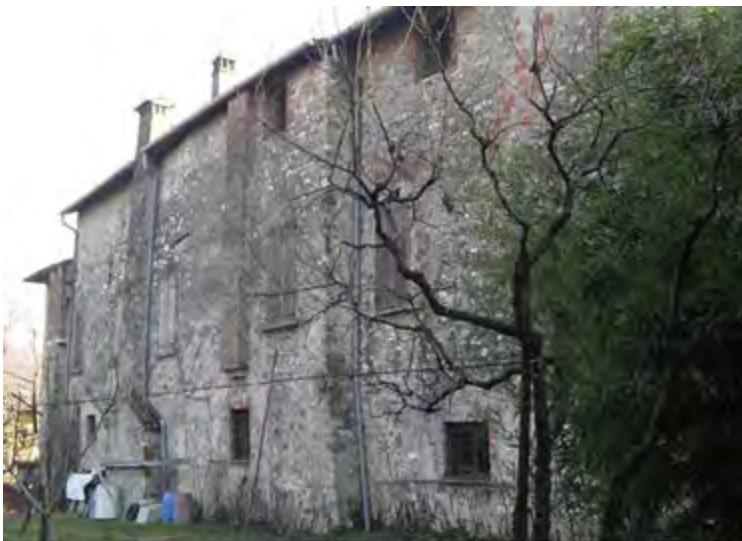
Figura 11. Gussago, Brescia, cascina in località Lóc de la Begia. È interessante rilevare la stratificazione dei sistemi di riscaldamento aggiunti in vari tempi, addossati alla muratura principale (foto B. Scala).
