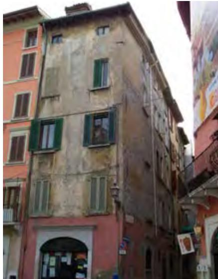
Da sinistra, figura 16. Brescia, palazzetto. L'edificio è situato nel centro storico della città (foto B. Scala); figura 17. Brescia, palazzetto. Dalle lacune di intonaco emerge la pietra di Medolo con cui è realizzata gran parte dell'architettura storica cittadina (foto B. Scala).
