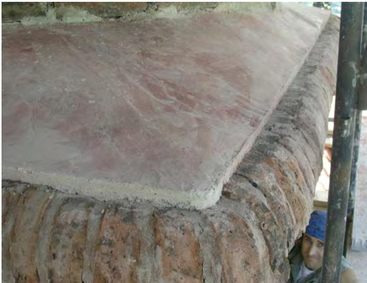
Figura 42. Protezione di uno sporto con malta in cocchiopesto (foto B. Scala).
