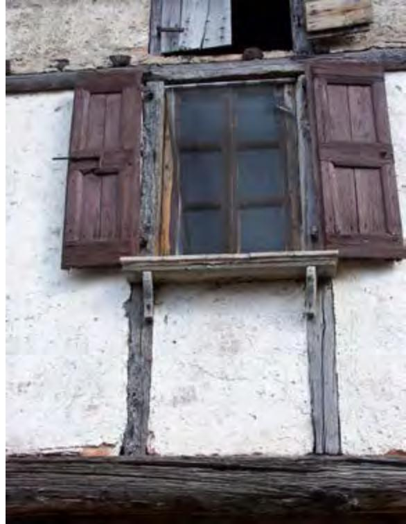
Da sinistra, figura 34. Salò, Brescia, edificio residenziale. La muratura esterna è in listelli di legno rivestiti di intonaco demolito durante i lavori di ristrutturazione (foto A. Fontanini); figura 35. Marcheno, Brescia. Muratura realizzata con struttura portante in legno e tamponamenti in mattoni disposti in foglio (foto B. Scala).
