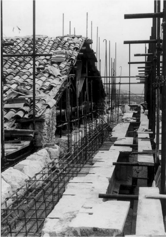
12. Una foto di dettaglio mostra le armature dei pilastri e le staffe di collegamento con gli elementi lapidei ricollocati (dal sito dell'impresa Cingoli).
