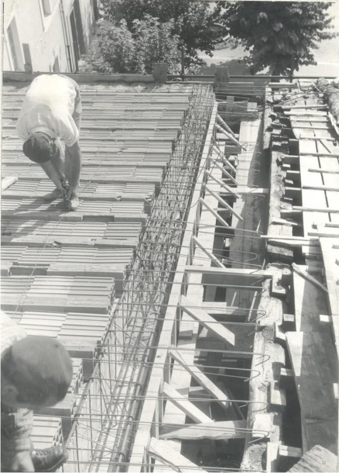
13. Il rifacimento delle coperture fu compiuto sostituendo la struttura lignea con solai in laterocemento e cordoli in calcestruzzo armato ((SABAP-Aq 1960).
