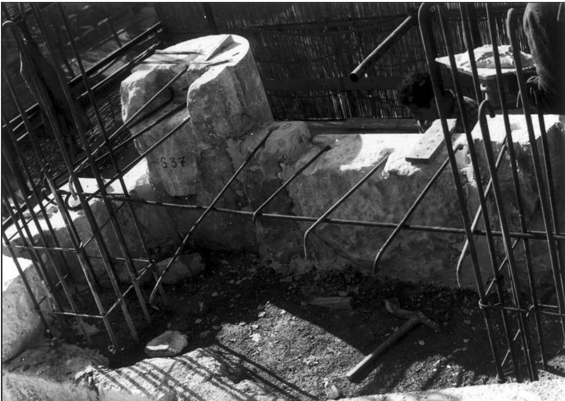
12. Una foto di dettaglio mostra le armature dei pilastri e le staffe di collegamento con gli elementi lapidei ricollocati (dal sito dell'impresa Cingoli).
