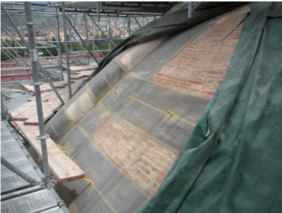
6. La cupola durante i lavori di consolidamento dopo il sisma del 2009 (autore 2011).
