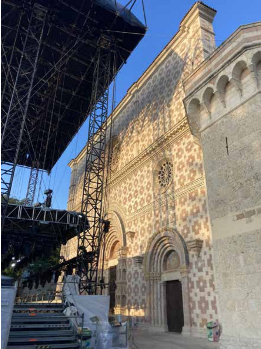
Figura 4. L'Aquila, Santa Maria di Collemaggio. Il palco per gli spettacoli della Perdonanza Celestiniana, collocato presso la facciata della basilica, costituisce un ingombro visivo e un elemento di pericolosità (possibili danni per urti e vibrazioni) oltre a ridurre l'architettura a mera scenografia per la celebrazione di un "patrimonio intangibile" (foto C. Bartolomucci, 2023).
