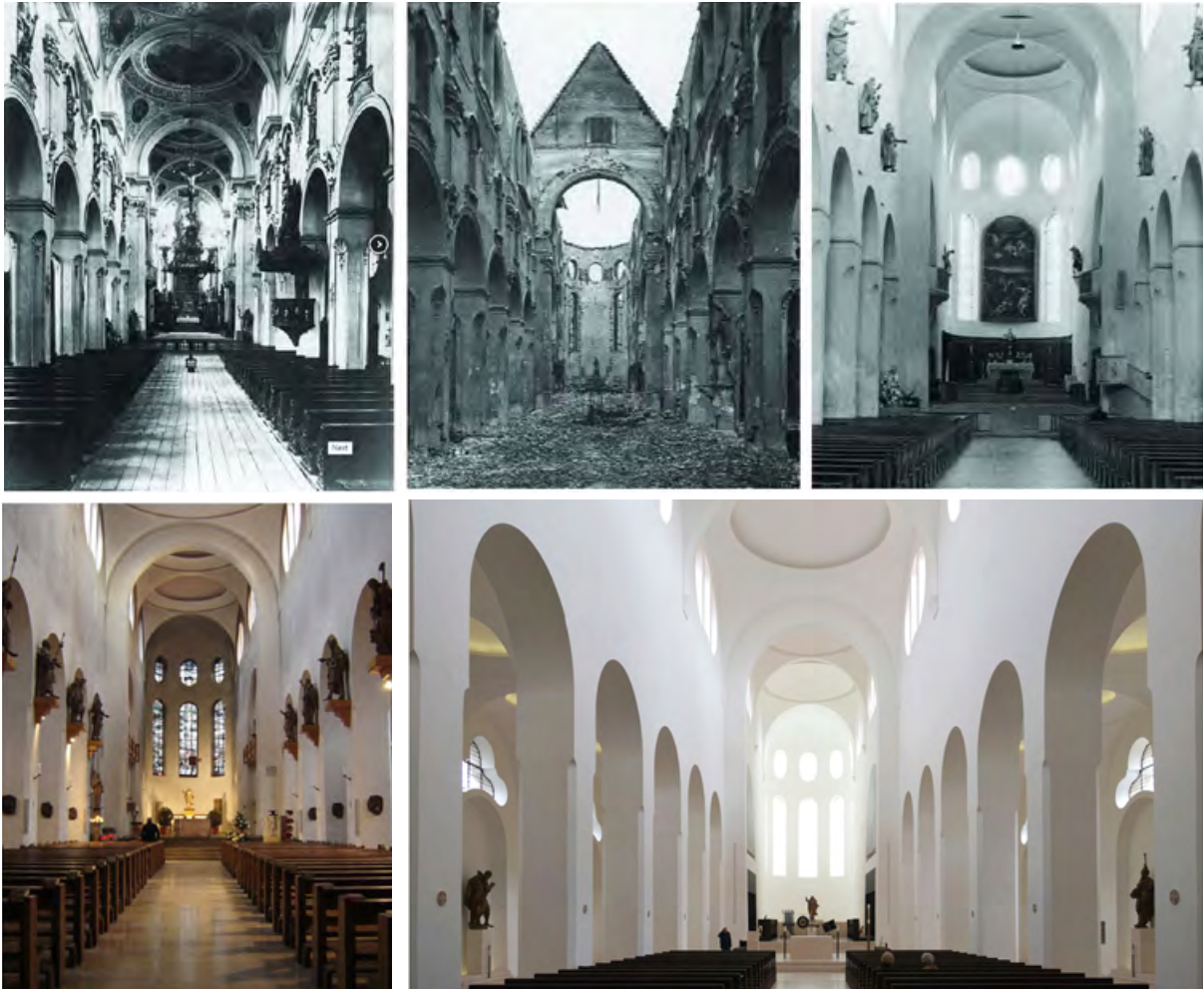
Figura 11. Moritzkirche ad Augusta, in Germania: veduta della chiesa rispettivamente nel 1714, nel 1944, nel 1946, nel 2007 e nel 2016. La chiesa medievale, privata della copertura e dei rivestimenti dai bombardamenti, è stata ricomposta nel dopoguerra con la ricostruzione delle volte e il rifacimento delle finiture. Il nuovo recente rifacimento degli intonaci e delle tinte ha particolarmente accentuato l'essenzialità dei volumi, esaltati nella loro purezza dalla disposizione di un intonaco bianco liscissimo ( http://www.moritzkirche.de/kirche-st-moritz ).
