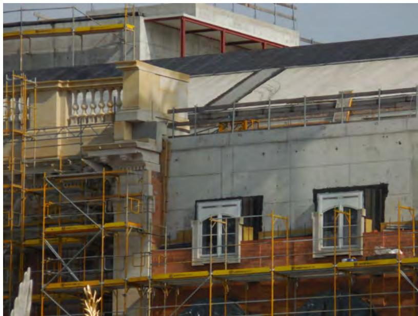
Figura 9. Cantiere di ricostruzione dello Schloss a Berlino. Il dettaglio mostra la fase di rivestimento in pietra e mattoni della struttura portante in cemento armato (foto D. Fiorani, agosto 2016).
