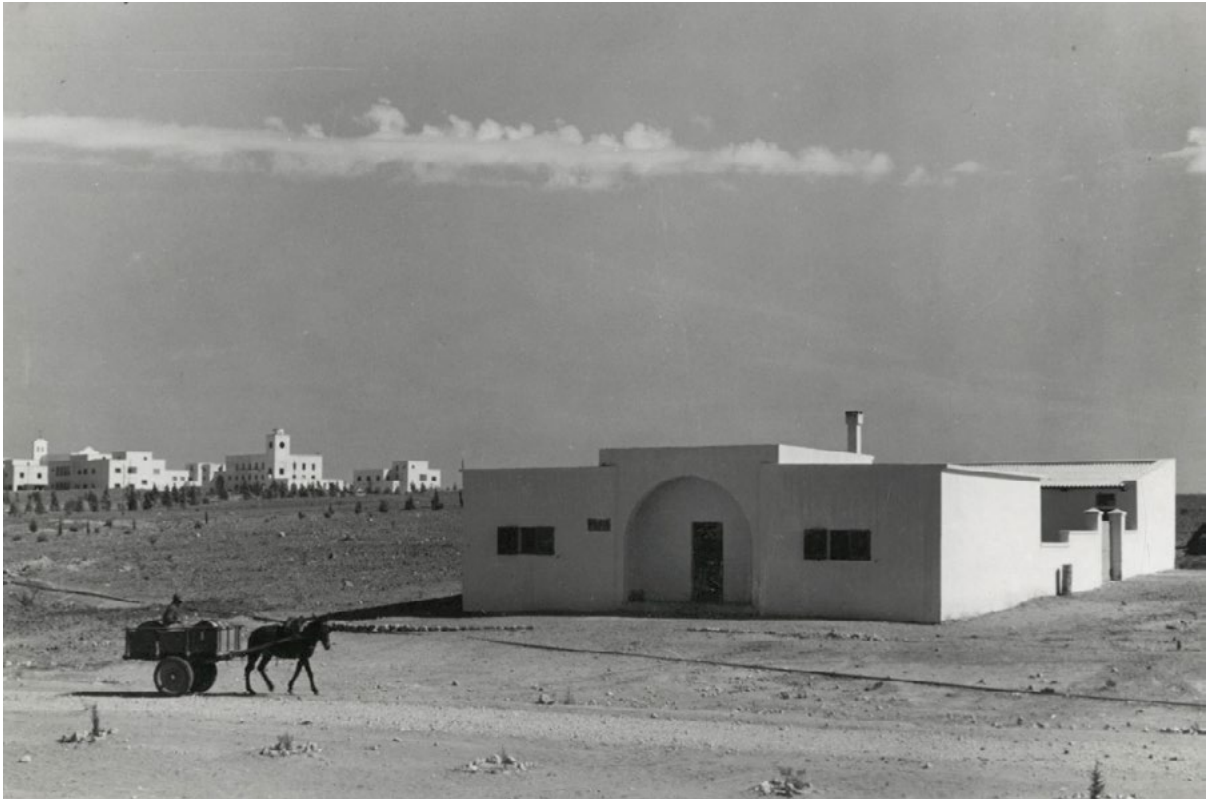
Figura 41. Tarhuna (Misurata), villaggio Arturo Breviglieri, Umberto Di Segni, veduta generale e in primo piano una delle case coloniche del comprensorio. Biblioteca civica di Belluno - fondo fotografico - Album, Vedute della Libia anni '30-'40 .
