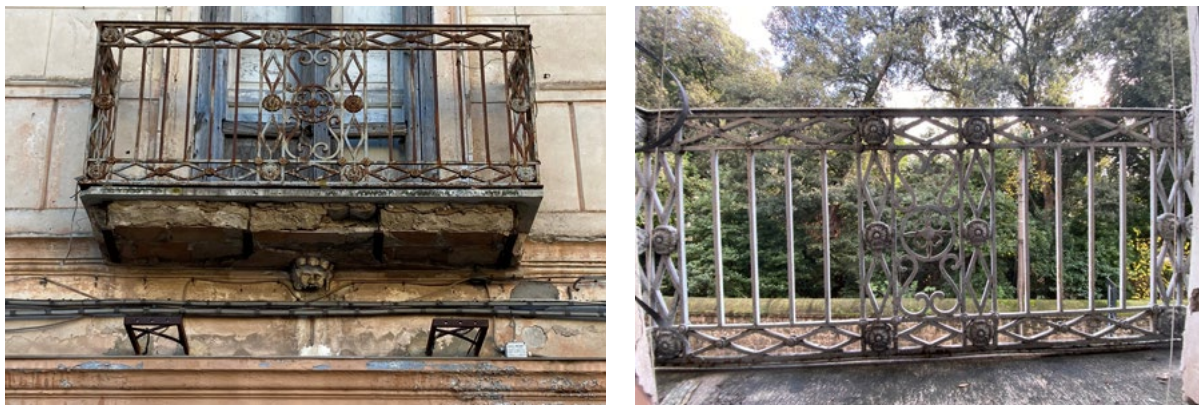
Figure 15-16. Caserta, Palazzo de Gregorio, particolare delle ringhiere dei balconi ottocenteschi al piano nobile (foto M.G. Pezone, 2021).
