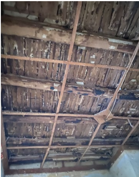
Figure 17-19. Caserta, Palazzo de Gregorio, solai di copertura in legno di diversi ambienti, particolari (foto M.G. Pezone, 2021).
