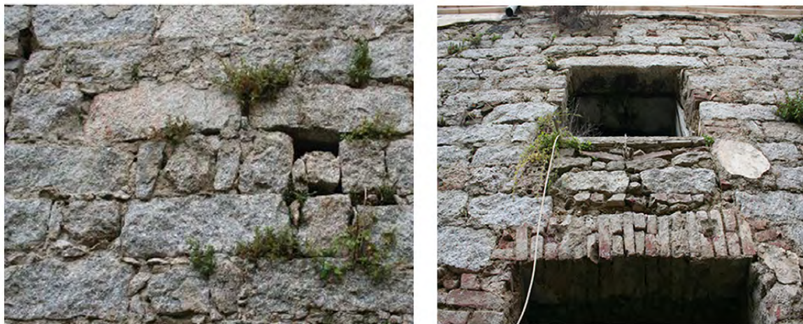
Figure 4a-b. Immagini di paramenti murari in conci di granito.
