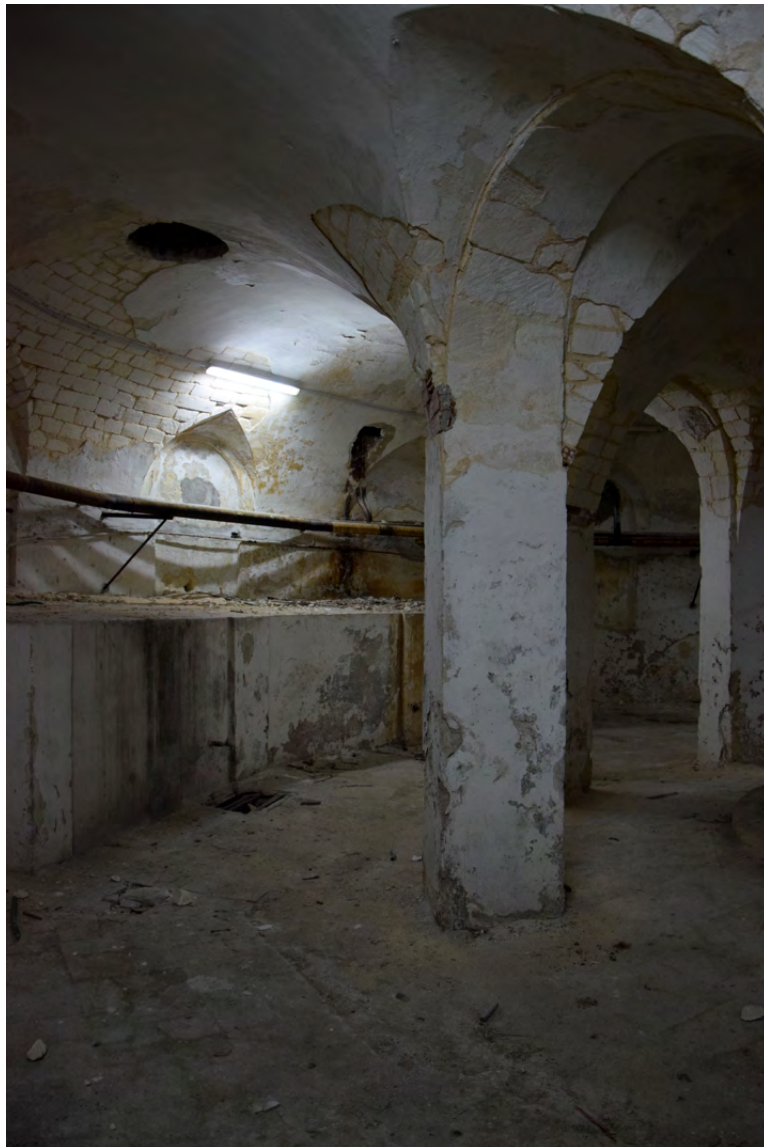
Figura 8. Sassari, carcere di San Sebastiano. La rotonda centrale, piano seminterrato (foto G.B. Cocco 2020).
