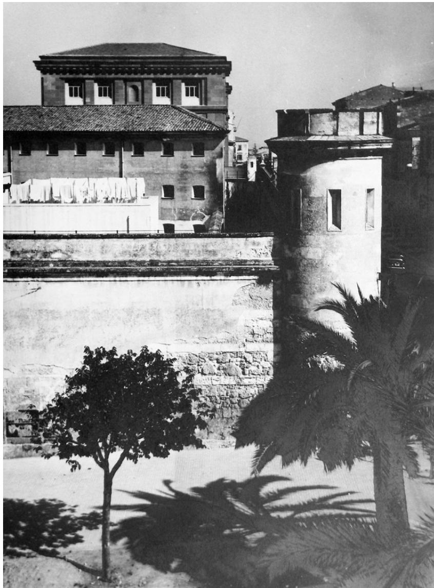
Figura 5. Sassari, Carcere di San Sebastiano. Stato di fatto del muro di cinta lungo la via Giorgio Asproni alla fine degli anni Cinquanta del Novecento. Si noti l'estesa lacuna di intonaco sul muro di cinta che rivela la tecnica muraria e i materiali impiegati nella sua costruzione. ASGC, Sassari, Carcere di San Sebastiano, Progetto di Sistemazione e Ampliamento (1957-1961).
