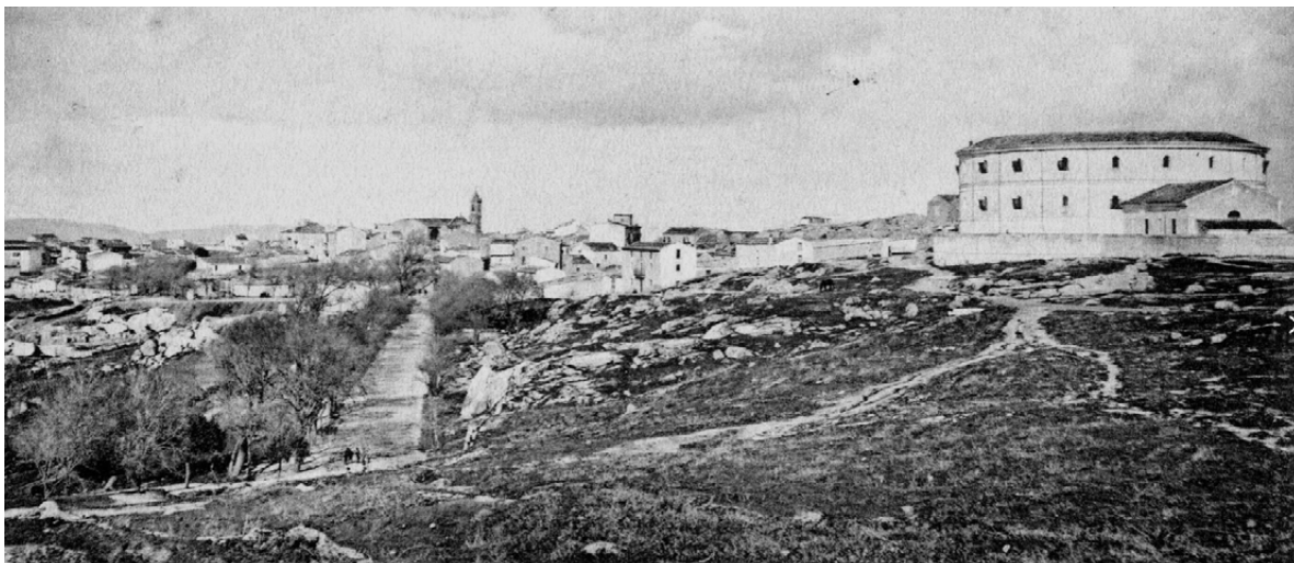
Figura 6. Tempio Pausania, panorama storico. Il carcere, sul bordo destro dell'immagine, è ben riconoscibile in posizione sopraelevata e ancora non circondato dal tessuto edilizio urbano (s.d. ma post 1870). L'edificio esibisce già il terzo livello, ma conserva ancora intatta la cappella retrostante, che appare ancora direttamente collegata a "La Rotonda".
