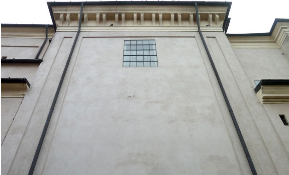
Figura 11. Pontevecchio (Brescia), chiesa dei Santi Tommaso e Andrea Apostoli, dettaglio della decorazione a fasce in testata al transetto (foto E. Sala, 2022).
