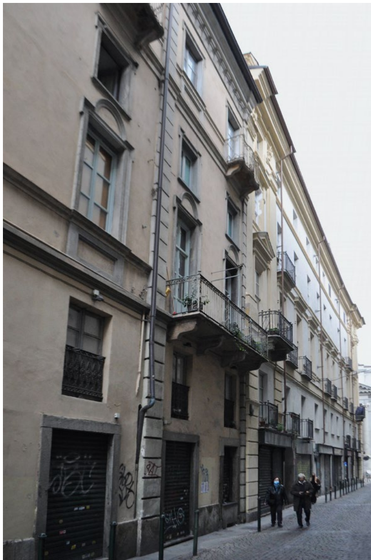
Figura 5. Torino. Palazzo Novarina di San Sebastiano, particolare del fronte su strada. Le due campate di destra sono frutto di una applicazione parziale del progetto vittoniano del 1767 (foto E. Piccoli, 2020).
