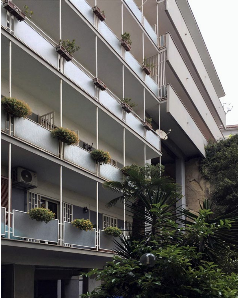
Figura 8. Stefania Filo Speziale, fabbricato in via Petrarca: particolare della struttura "a ponte" dal lato dell'accesso principale in via Parco Carelli (foto C. De Falco, 2022).
