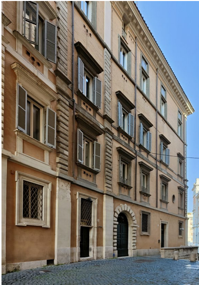
Figura 8. Roma, palazzo già dei padri della Missione, oggi della Camera dei Deputati, facciata su via della Missione corrispondente alla facciata di palazzo Toschi (foto T. Manfredi, 2022).
