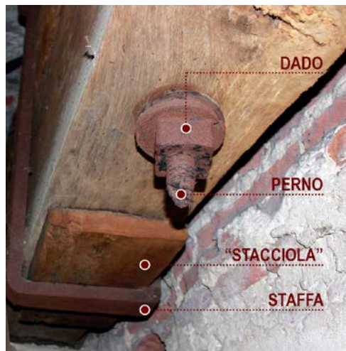
Figura 16. Perno dei giunti di tipologia E (vano 17, vela 6). Si osservino il dado quadrato, avvitato al fusto filettato, e la "stacciola" in legno. (foto e elaborazione S. Celli, 2018).
