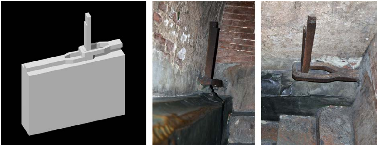
Figura 9a-c. Giunti di tipologia C: modello 3D e vano 8 (foto ed elaborazione S. Celli, F. Ottoni, 2018).
