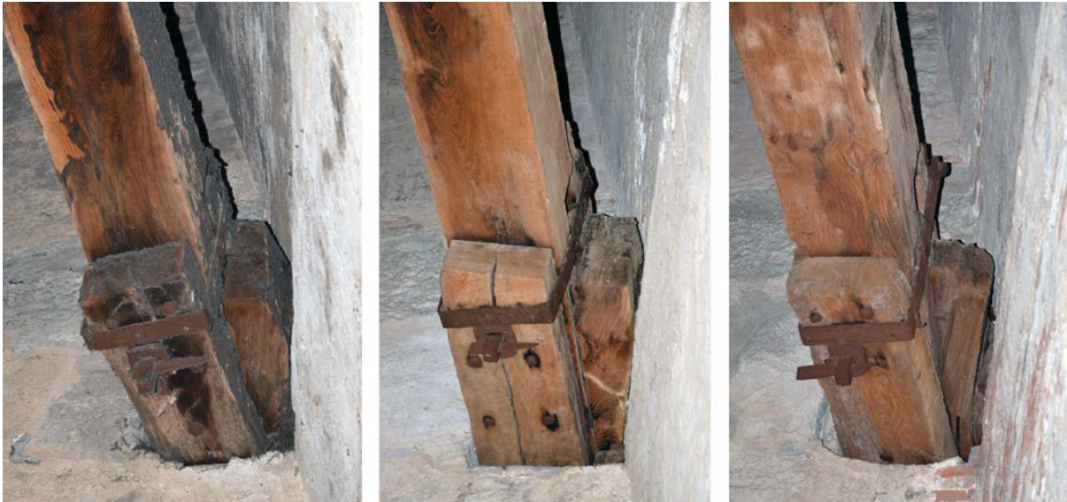
Figure 4a-c. I tre giunti rappresentati in figura (da sinistra a destra: vano 10, 13 e 19) mostrano in maniera abbastanza evidente alcuni dettagli del sistema di connessione che non compaiono nel rilievo del Nelli (foto S. Celli, 2018).
