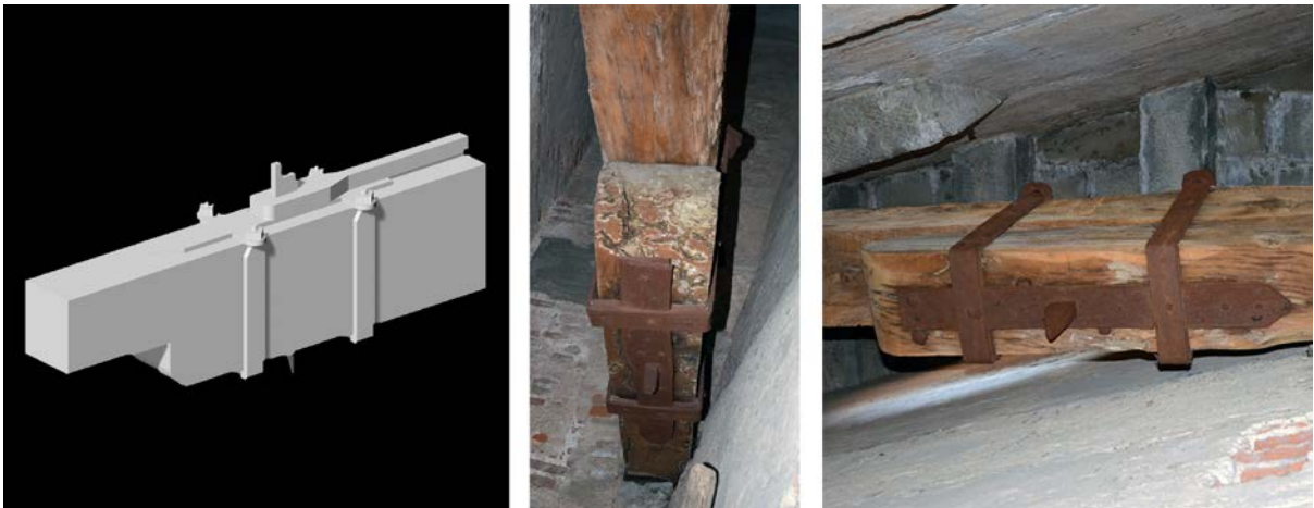
Figura 10a-c. Giunti di tipologia D: modello 3D, vano 22 e vano 15 (foto ed elaborazione S. Celli, F. Ottoni, 2018).
