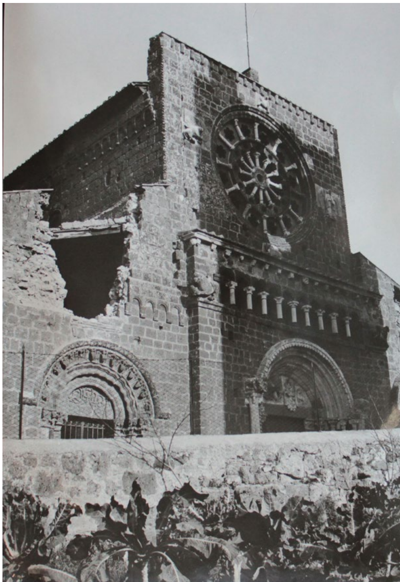
Figura 19. La facciata all'indomani del terremoto (foto esposta all'interno della chiesa).
