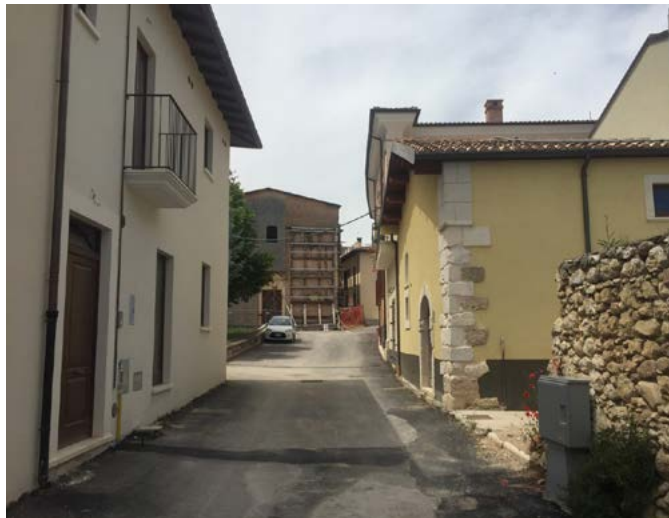
Figura 9. Villa Sant'Angelo (AQ), giugno 2020. Sullo sfondo, la piazza con la chiesa puntellata e nascosta da sbadacchiature; in primo piano un frammento murario scampato alla demolizione. Gli edifici ricostruiti mostrano sostituzioni edilizie e rifacimenti incongrui, in cui gli "elementi di pregio" recuperati sono estraniati dal contesto e privati di qualsiasi significato (foto C. Bartolomucci, 2020).
