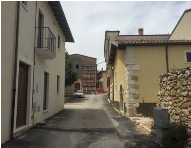
Figura 9. Villa Sant'Angelo (AQ), giugno 2020. Sullo sfondo, la piazza con la chiesa puntellata e nascosta da sbadacchiature; in primo piano un frammento murario scampato alla demolizione. Gli edifici ricostruiti mostrano sostituzioni edilizie e rifacimenti incongrui, in cui gli "elementi di pregio" recuperati sono estraniati dal contesto e privati di qualsiasi significato (foto C. Bartolomucci, 2020).
