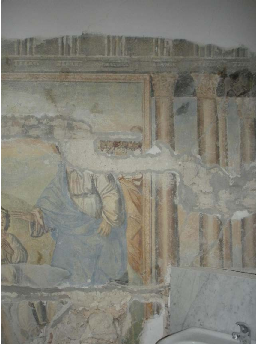
Figura 8. L'Aquila, palazzo Branconio, ottobre 2009. L'edificio, che presentava ambienti dipinti di notevole interesse (XVI secolo), è stato oggetto di rimozioni generalizzate dopo il sisma del 2009: gli affreschi sono stati staccati ovunque, ancor prima della documentazione del danno. Nella foto, un residuo dei dipinti in un ambiente di servizio (foto C. Bartolomucci, 2009).
