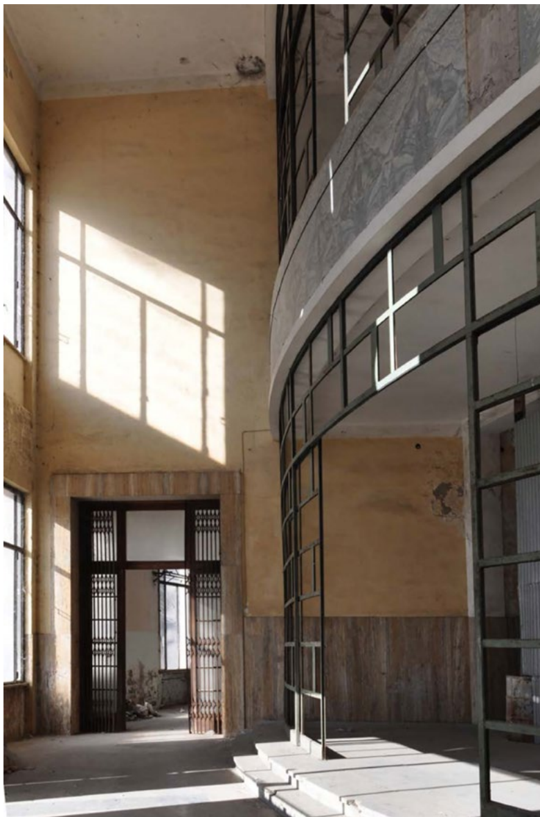
Figura 5. Predappio (Forlì-Cesena). Casa del Fascio. Dettaglio dell'atrio con vetrata scorrevole in ferro al livello terreno e al livello superiore, in corrispondenza del pianerottolo dello scalone (da DELIZIA ET ALII 2015, p. 68).
