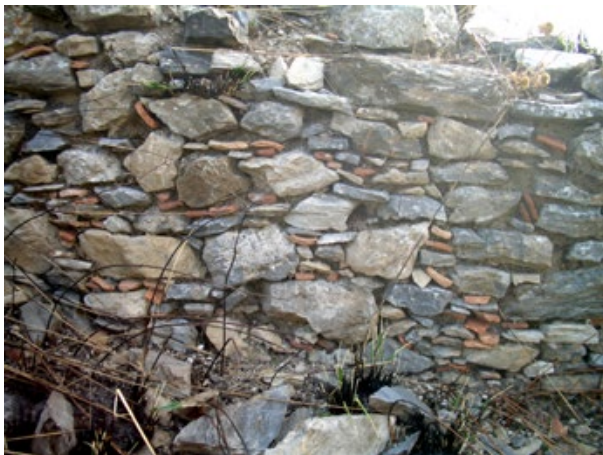
Figura 11. Particolare della muratura ricorrente nel sito, costituita in pietrame informe rinzeppato con cocci di laterizi (foto C. Genovese, 2016).
