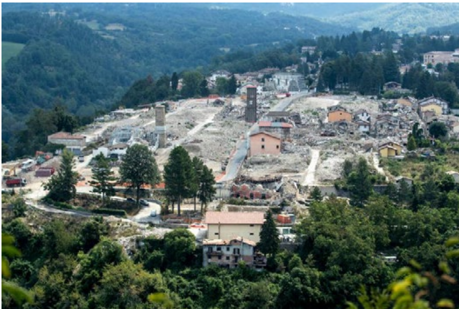
Figura 11. Amatrice allo stato attuale: sono evidenti le demolizioni di interi isolati del tessuto edilizio storico, https://www.ilfoglio.it/cronache/2018/08/24/gallery/amatrice-due-anni-dopo-210890/ (ultimo accesso 29 marzo 2019).
