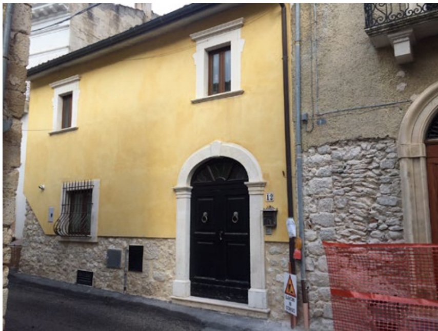
Figura 14. Carapelle Calvisio (L'Aquila). Gli esiti della ricostruzione in corso sulla via principale di accesso al paese. Il nucleo storico è ancora in abbandono (foto C. Bartolomucci, 2018).
