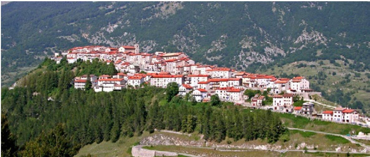
Figura 9. Opi (L'Aquila). La foto attuale mostra l'espansione del borgo e diverse sostituzioni edilizie realizzate dopo il sisma del 1984 (foto C. Bartolomucci, 2014).
