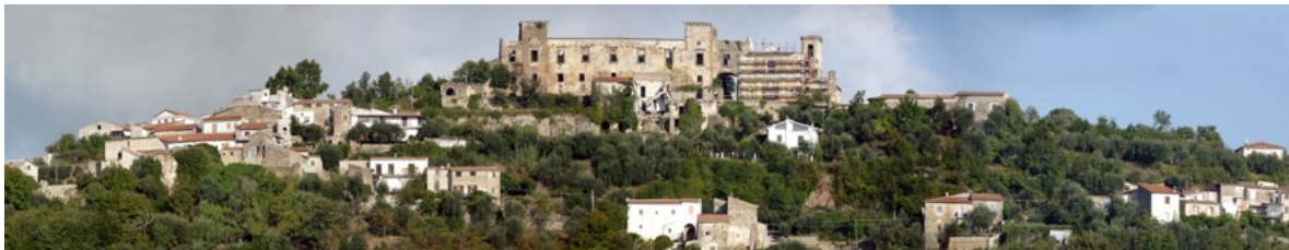
Figura 2. Terracorpo. Il fronte meridionale del borgo dal drone (foto M. Facchini, 2015).
