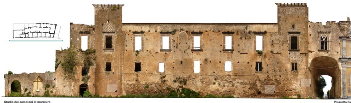
Figura 8. Terracorpo. Fronte meridionale del castello (elaborazione di S. Caldarelli, a.a. 2013-2014).
