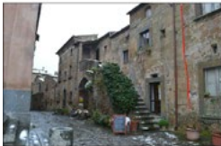
Prospetto esterno nord-ovest
