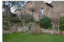
Prospetto esterno sud-est
