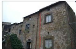
Prospetto esterno nord-ovest
