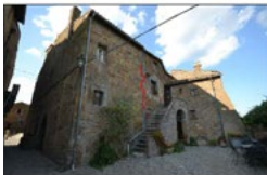
Prospetto esterno sud-est
