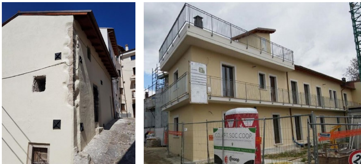
Figura 15. Esempi di interventi successivi al terremoto del 2009. L'immagine a sinistra ritrae un edificio di Rocca di Mezzo (L'Aquila) oggetto di riparazioni e rinforzi antisismici. In particolare si nota il rifacimento dell'intonaco esterno sostituito con un premiscelato fibro-rinforzato di notevole spessore, tale da sovrapporsi, erroneamente, agli stipiti delle aperture; sono inoltre parzialmente lasciate in vista le pietre dell'angolata con un esito nel complesso trasfigurante (foto A. Donatelli, 2019). Nell'immagine a destra si osserva un aggregato ricostruito in sagoma, con una struttura in cemento armato, nella frazione di Onna (L'Aquila), gravemente danneggiata dal recente sisma (foto A. Donatelli, 2017).
