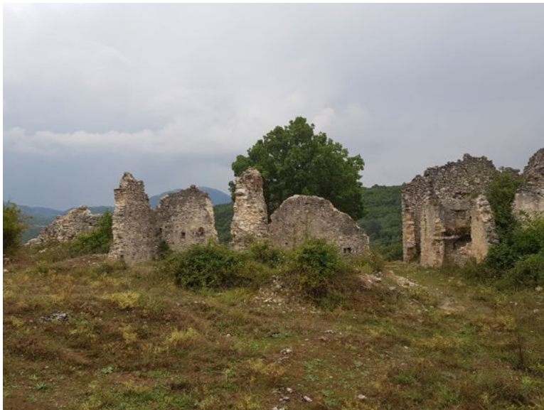
Figura 13. Lecce nei Marsi Vecchia (L'Aquila). Veduta odierna dell'antico insediamento abbandonato dopo il sisma del 1915 e delocalizzato nella nuova Lecce nei Marsi, costruita a valle (foto A. Donatelli, 2018).
