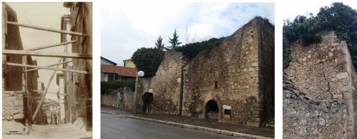
Figura 11. Magliano dei Marsi (L'Aquila). L'immagine storica a sinistra mostra le facciate di edifici presidiate, dopo il sisma del 1904, con grosse travi lignee poste in opera per contrastare possibili ribaltamenti delle pareti su strada (dalla Collezione Giuseppe di Girolamo pubblicata online: http://www.gvmprotezionecivile.it/memoria-sismica-magliano-dei-marsi/terremoti-storici-locali/terremoto-magliano-1904 , ultimo accesso novembre 2018). Le altre immagini mostrano alcuni immobili tuttora esistenti, reduci dai terremoti novecenteschi della Marsica e lasciati in completo stato di abbandono; in particolare nell'immagine di destra si nota una lesione inclinata visibile su una parete ortogonale al muro di facciata, effetto di un incipiente ribaltamento del fronte su strada (foto A. Donatelli, 2018).
