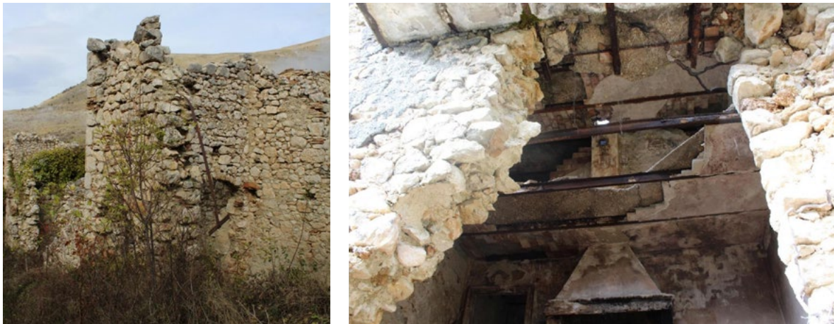
Figura 6. Frattura Vecchia, frazione di Scanno (L'Aquila). Dettagli costruttivi, come gli incatenamenti in ferro che corrono lungo lo spessore murario di diverse pareti e i solai in putrelle metalliche e voltine osservati in alcuni edifici disposti a valle della collina di insediamento del nucleo originario, denotano una seconda espansione dell'abitato databile fra la seconda metà del XIX secolo e i primi anni del XX (foto A. Donatelli, 2018).
