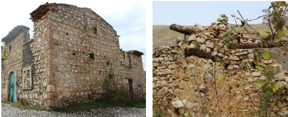
Figura 5. Frattura Vecchia, frazione di Scanno (L'Aquila). Dettagli costruttivi, quali la presenza di laterizi nella tessitura muraria e la disposizione di radiciamenti lignei lungo diverse pareti, inducono a ipotizzare una fase di espansione dell'abitato riconducibile alla seconda metà del XVIII (foto A. Donatelli, 2018).
