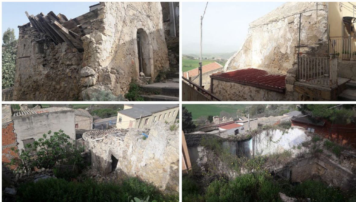
Figura 9. L'avanzamento dei crolli e delle ruderizzazioni nelle abitazioni abbandonate (foto di R. Ledda, 2018).
