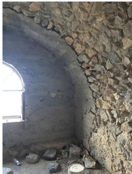
Figura 12. Esempi di interventi post sismici in calcestruzzo: realizzazione di un cordolo all'imposta della cupola di una chiesa e ricostruzione di una porzione di parete e di volta in una casa (foto C.F. Carocci, 2018).
