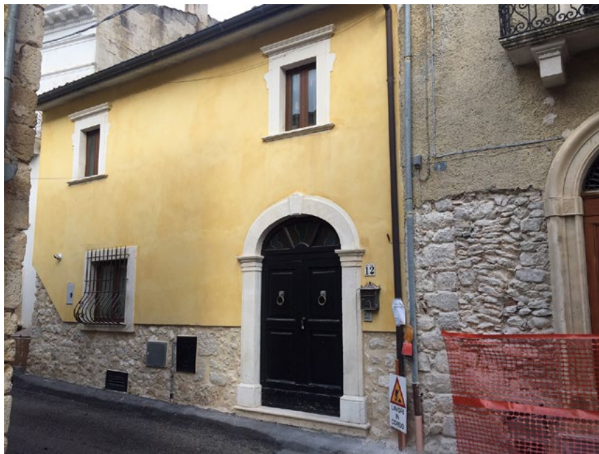
Figura 14. Carapelle Calvisio (L'Aquila). Gli esiti della ricostruzione in corso sulla via principale di accesso al paese. Il nucleo storico è ancora in abbandono (foto C. Bartolomucci, 2018).
