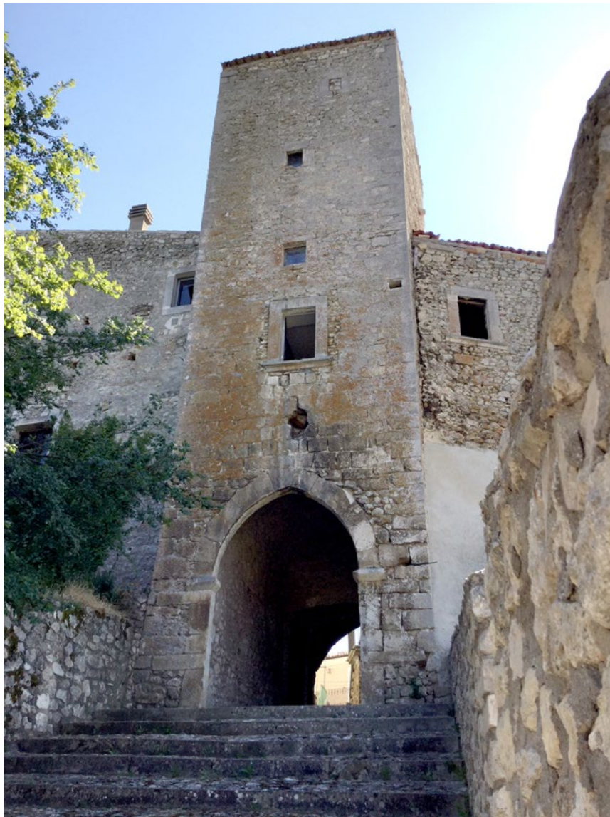
Figura 1. Collepietro (L'Aquila). Una porzione delle "case-mura" che caratterizzano il nucleo storico (foto C. Bartolomucci, 2018).
