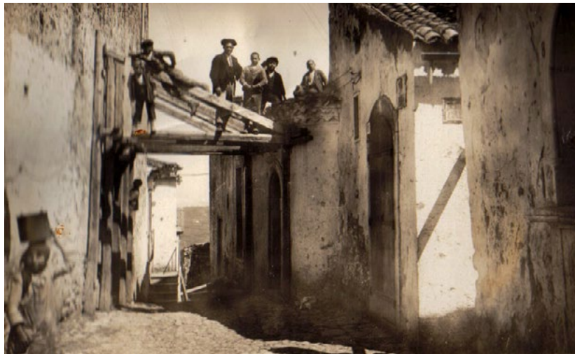
Figura 7. Foto d'epoca del centro storico di Accadia dopo il terremoto del 1930. Molte abitazioni seppur danneggiate sono in piedi ed è interessante come subito si provveda alla messa in sicurezza attraverso puntellamenti che si basano sugli stessi principi dei presidi sismici premoderni, quali archi di collegamento e speroni (da Comune di Accadia - Terremoto 1930, http://www.comune.accadia.fig.it/index.php?option=com_phocagallery&view=terremoto-1930&lang=it ) (ultimo accesso 28 marzo 2019).
