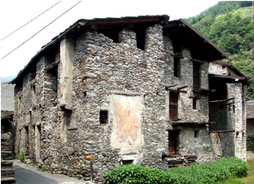
Figura 1. Ardenno (Sondrio), Case del nucleo al Piano (foto S. Della Torre, 2010).
