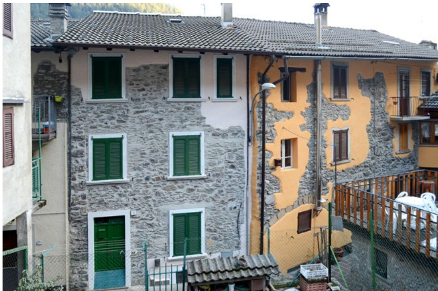
In alto, figura 11. Fortunago (Pavia). Totale scrape degli intonaci (foto B. Silva, 2018); a sinistra, figura 12. Mezzoldo (Bergamo). Rinnovo parziale scrape degli intonaci (foto B. Silva, 2018).
