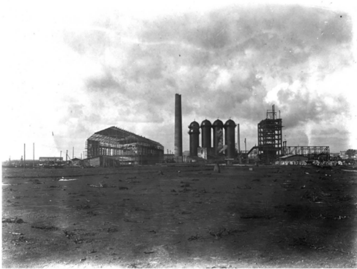
Figura 7. L'Ilva in costruzione nel 1909 ca. (Napoli, Archivio Italsider Bagnoli).
