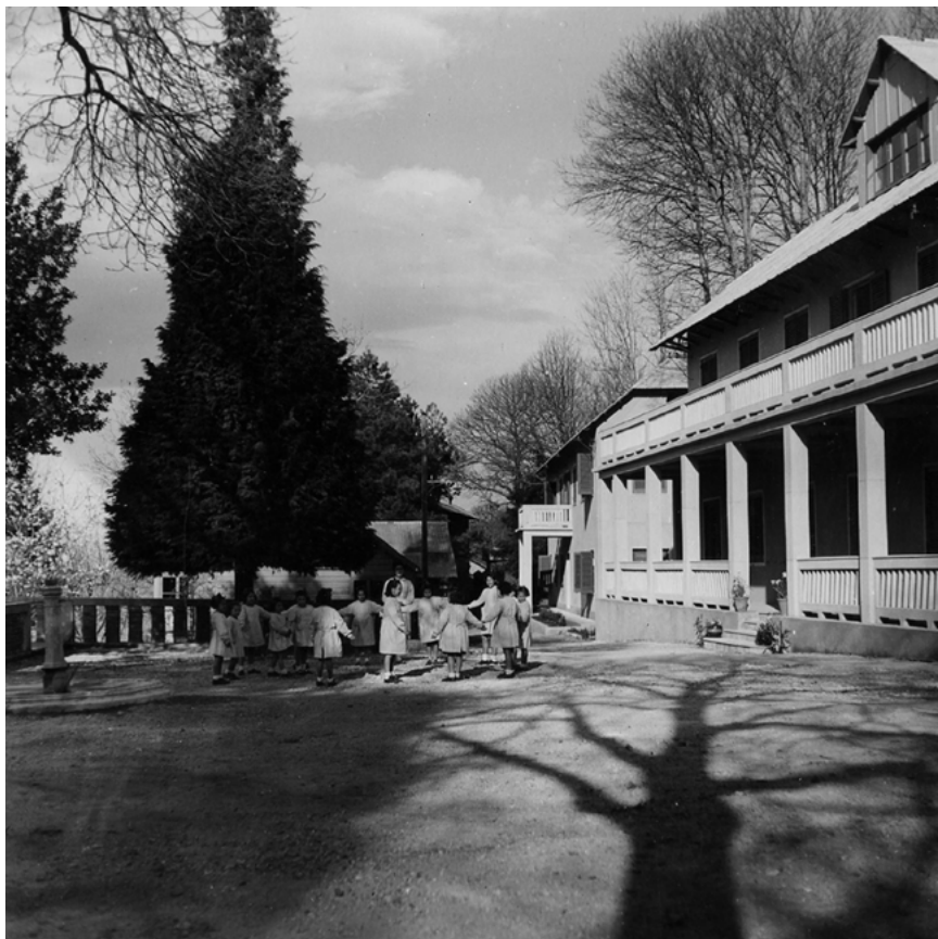
Figura 6. Sant'Alessio in Aspromonte (Reggio Calabria). La colonia Leopoldo Franchetti, a pochi chilometri dal paese, dopo la ristrutturazione di metà Novecento. Un elemento di sottotesto necessario per comprendere il caso del comune d'Aspromonte sono i cicli di riutilizzo dei numerosi immobili sorti in queste zone per scopo assistenziale o scolastico nel corso del XX secolo, poi abbandonati e ripresi in gestione da enti ecclesiastici, associazionismo e terzo settore (Archivio storico dell'Associazione nazionale per gli interessi del Mezzogiorno d'Italia, fondo Animi, serie Fotografie , sottoserie Assistenza e istruzione , fascicolo 327 Santo Stefano d'Aspromonte. Colonia Franchetti, asilo , https://tinyurl.com/yacnhqmf , ultimo accesso 28 agosto 2019).
