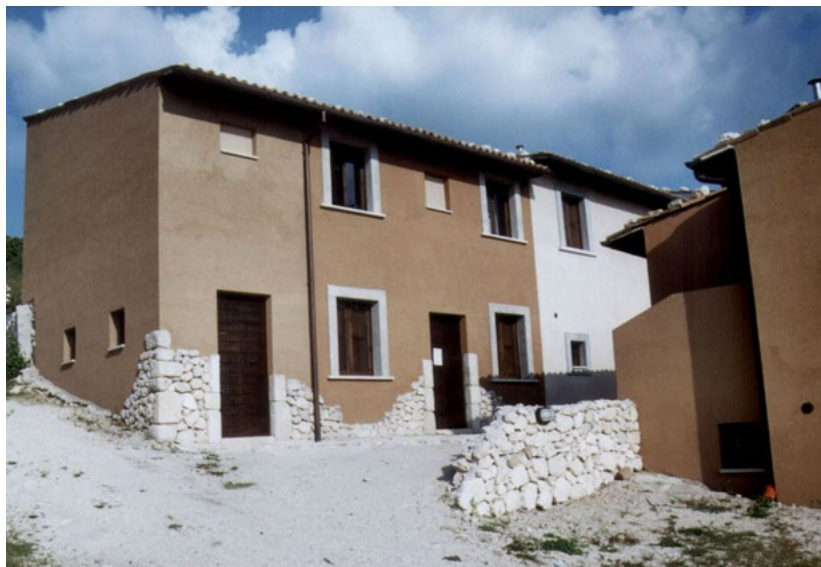
Figura 7a-b. Albe Vecchia (L'Aquila). Alcuni esempi di ricostruzione degli edifici ridotti a rudere, che giocano sul contrasto tra le antiche murature e i nuovi inserti (foto C. Varagnoli, 2006)
