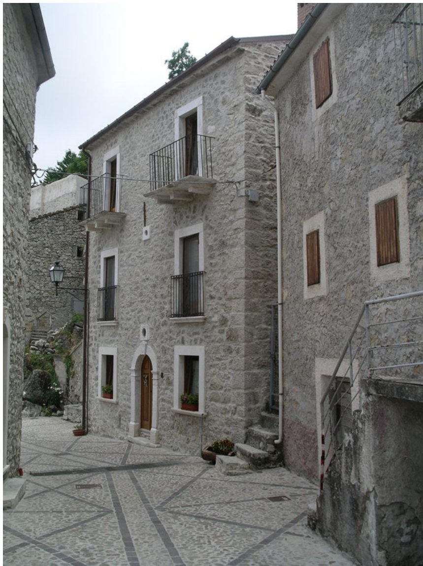
Figura 14. Roccacaramanico (Pescara). Esempi di ricostruzione totale o parziale del patrimonio edilizio diffuso (foto C. Varagnoli, 2006).
